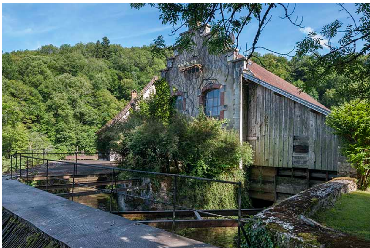
Prise d'eau, centrale hydroélectrique et bâtiment d'eau.
