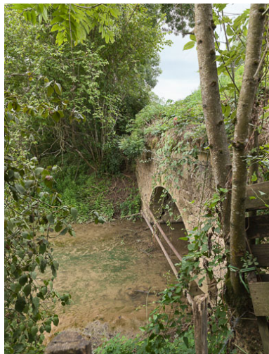
Vue de l'aqueduc.
