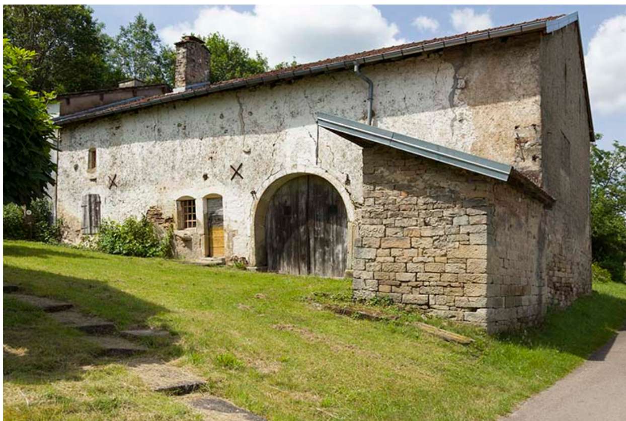
Ferme, perpendiculaire à la rue Principale (au 15.)
