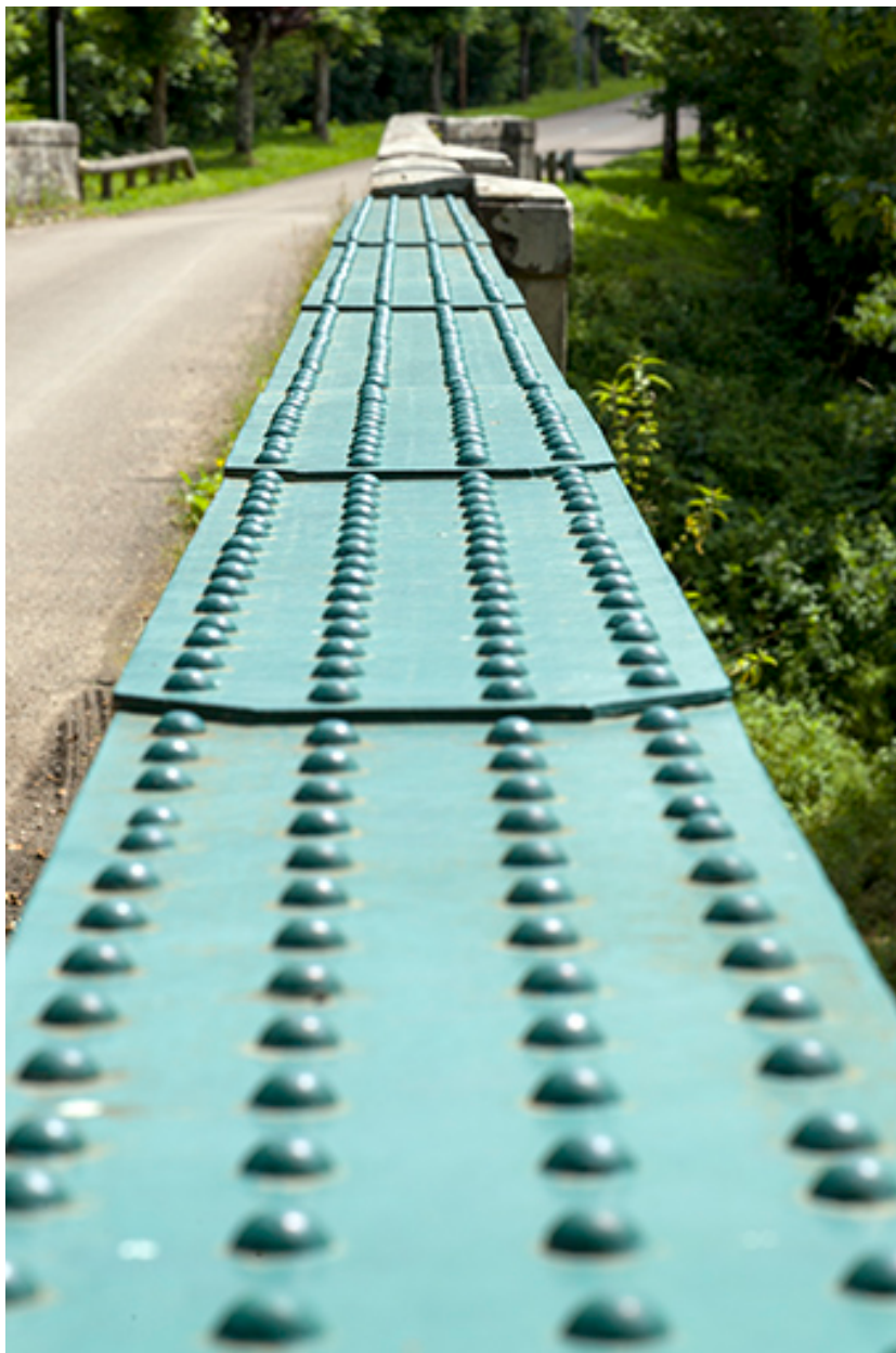
Détail de la rambarde de la passerelle.
