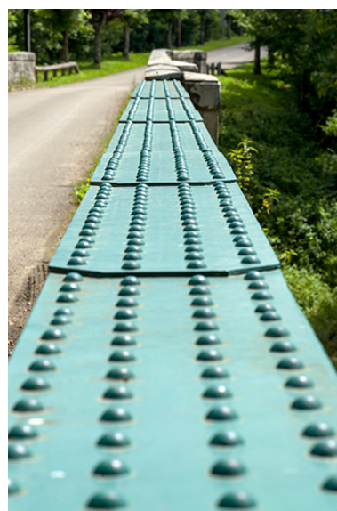
Détail de la rambarde de la passerelle.
