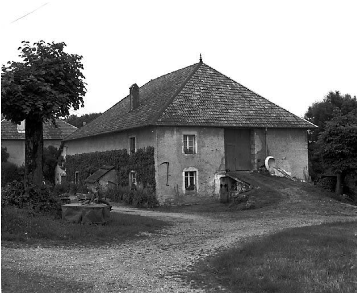
Façade antérieure et face latérale droite.
