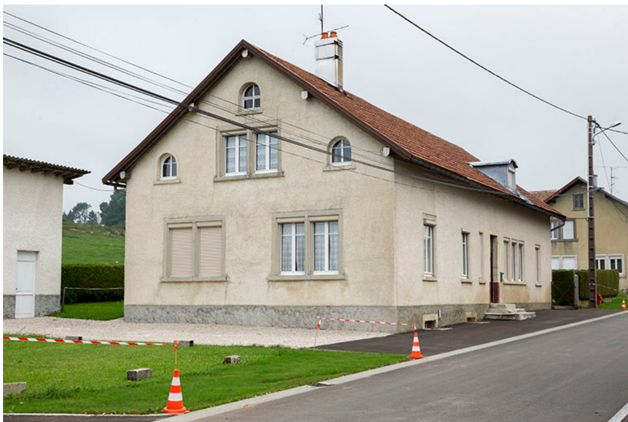
Façades antérieure et latérale gauche.
