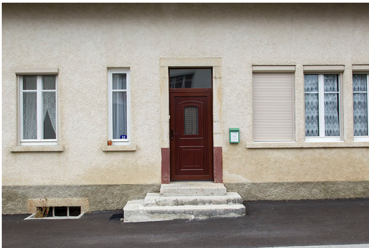
Façade antérieure : porte et fenêtres multiples.
