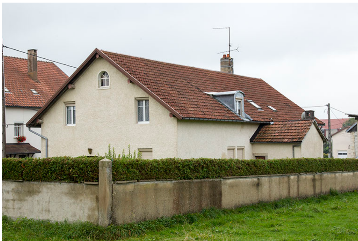
Façades postérieure et latérale droite.
