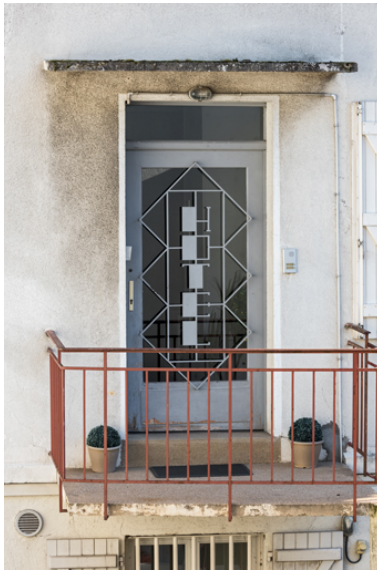
Porte sur cour de l'ancien hôtel. Phot. Pierre-Marie Barbe-Richaud IVR26_20238900204NUC4A
