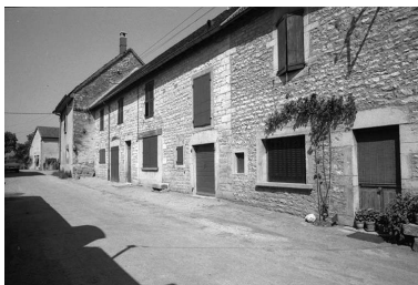
Maisons situées le long du chemin départemental n° 209 E. Phot. F. Pernin IVR43_19743900230Z
