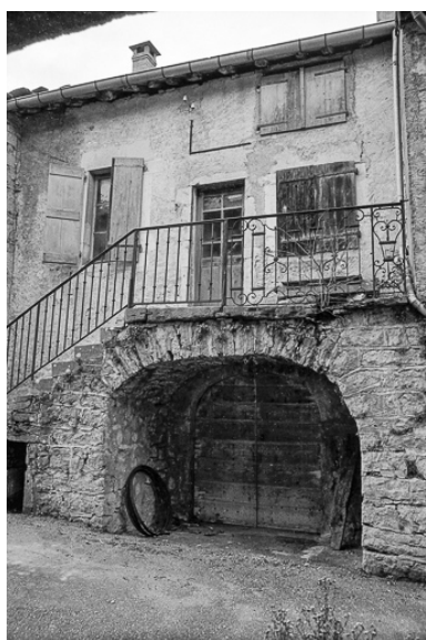
Maison de vigneron située impasse du Quart d'Amont. Phot. F. Pernin IVR43_19743900053Z
