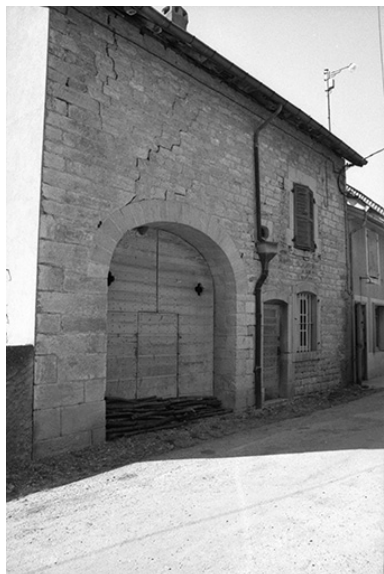
Ferme située le long du chemin départemental n° 209 E. Phot. F. Pernin IVR43_19743900228Z
