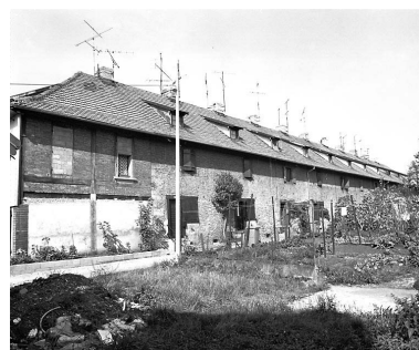
Façade côté jardins. Phot. Yves Sancey IVR43_19812500387X
