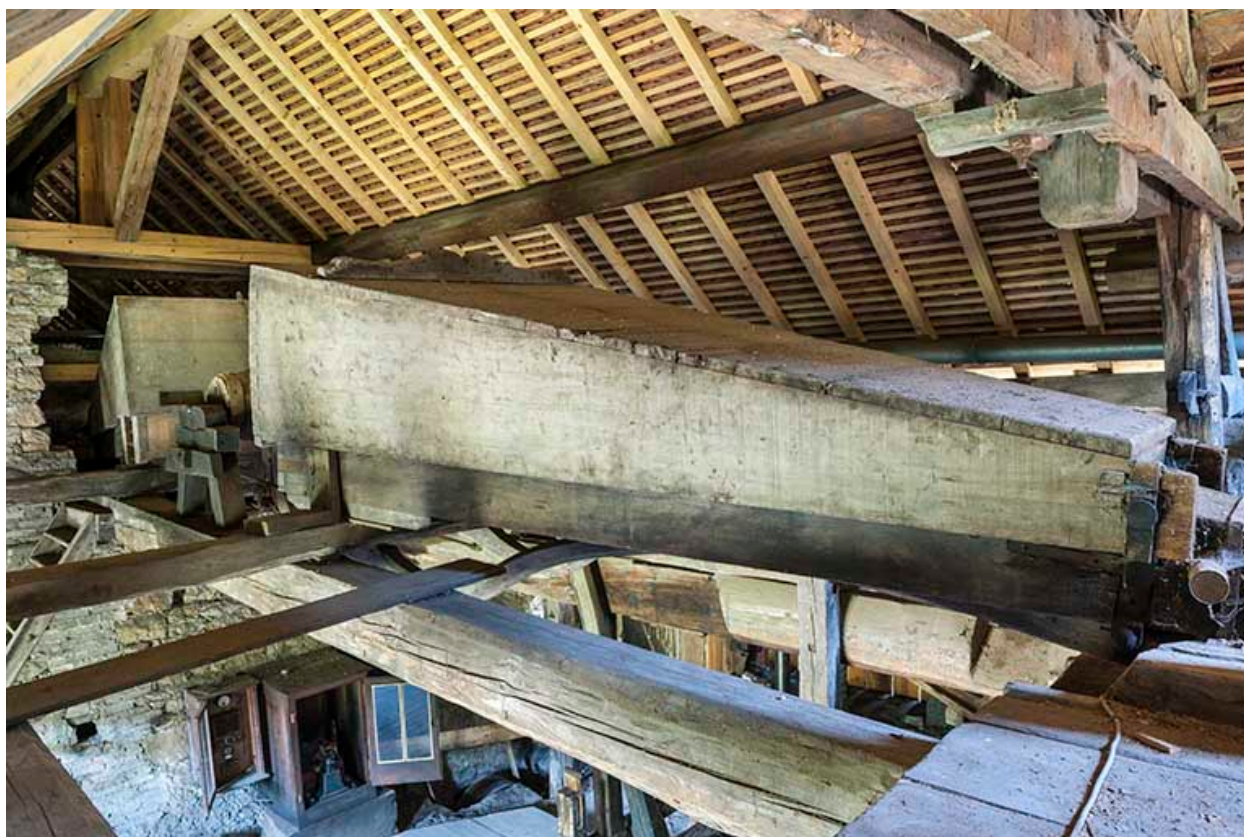
Caissons de la machine soufflante.
