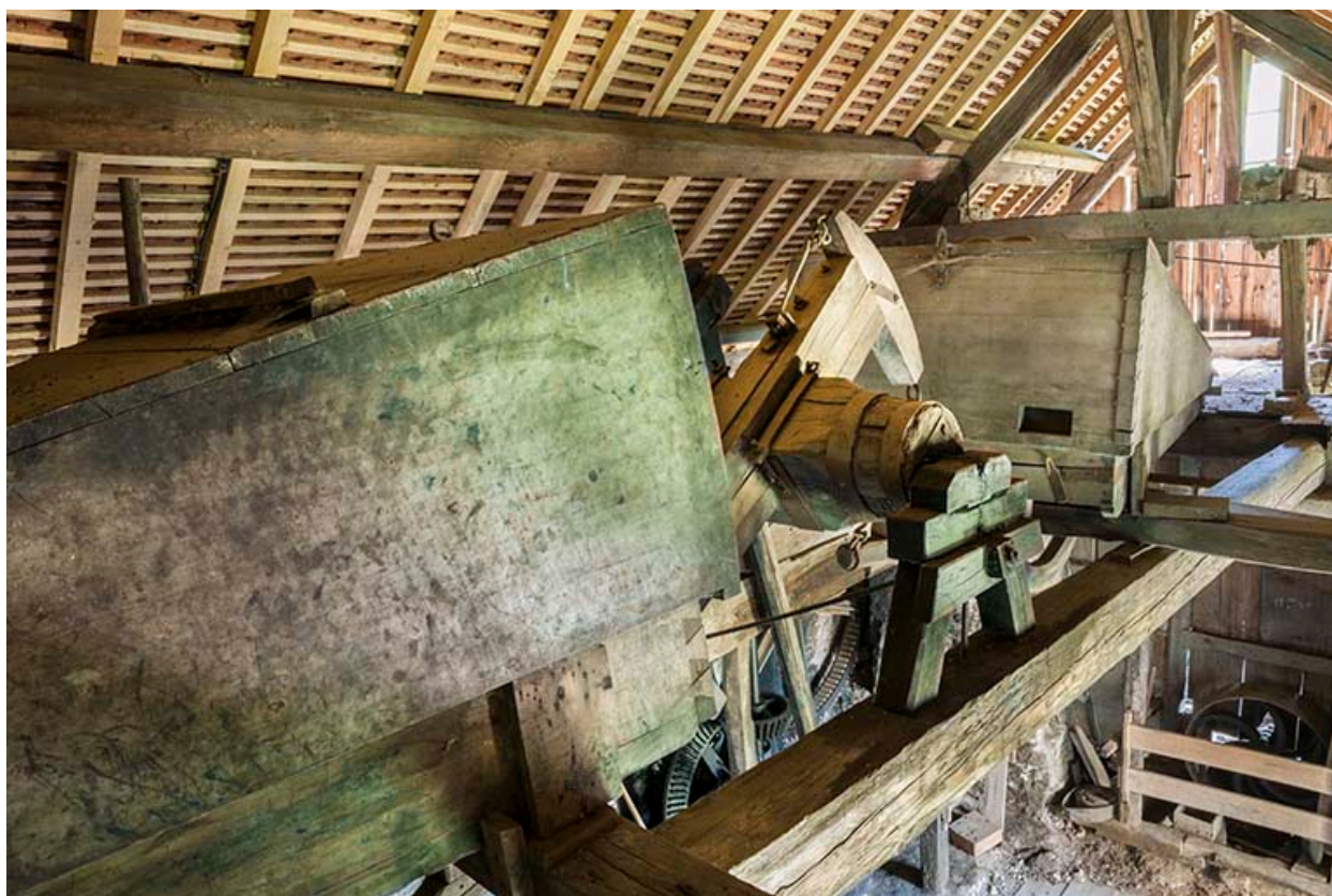
La machine soufflante vue du dessus.
