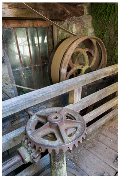
Au premier plan, système de contrôle de l'admission d'eau de la turbine hydraulique. Au second plan, poulies de renvoi vers les ateliers de forge et de mécanique.
