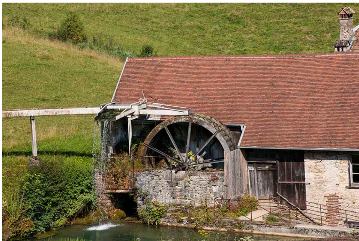
Roue hydraulique de la machine soufflante.
