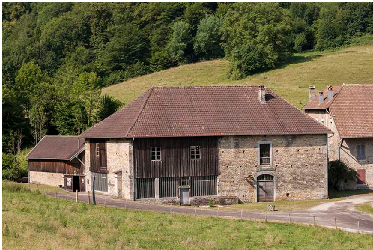
Façade nord de l'atelier de fabrication.
