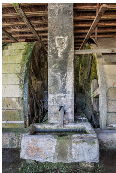
Les roues hydrauliques des martinets de part et d'autre du pilier central. Phot. Jérôme Mongreville IVR43_20152501543NUC4A
