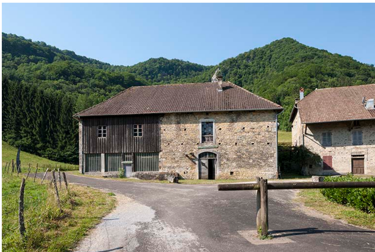
Façade antérieure de l'atelier de fabrication.
