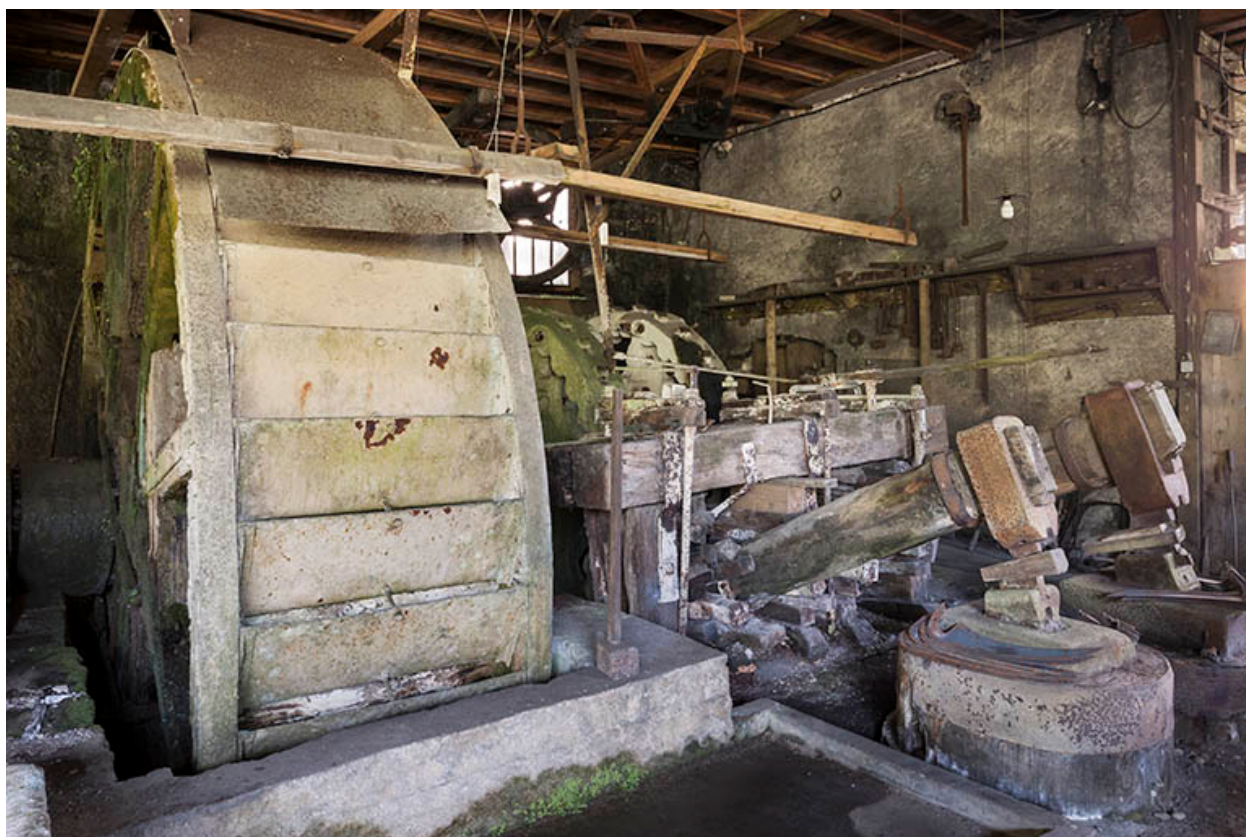
Roue hydraulique et les deux martinets ouest.
