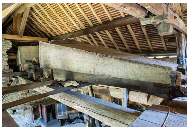
Caissons de la machine soufflante. Phot. Jérôme Mongreville IVR43_20152501582NUC4A
