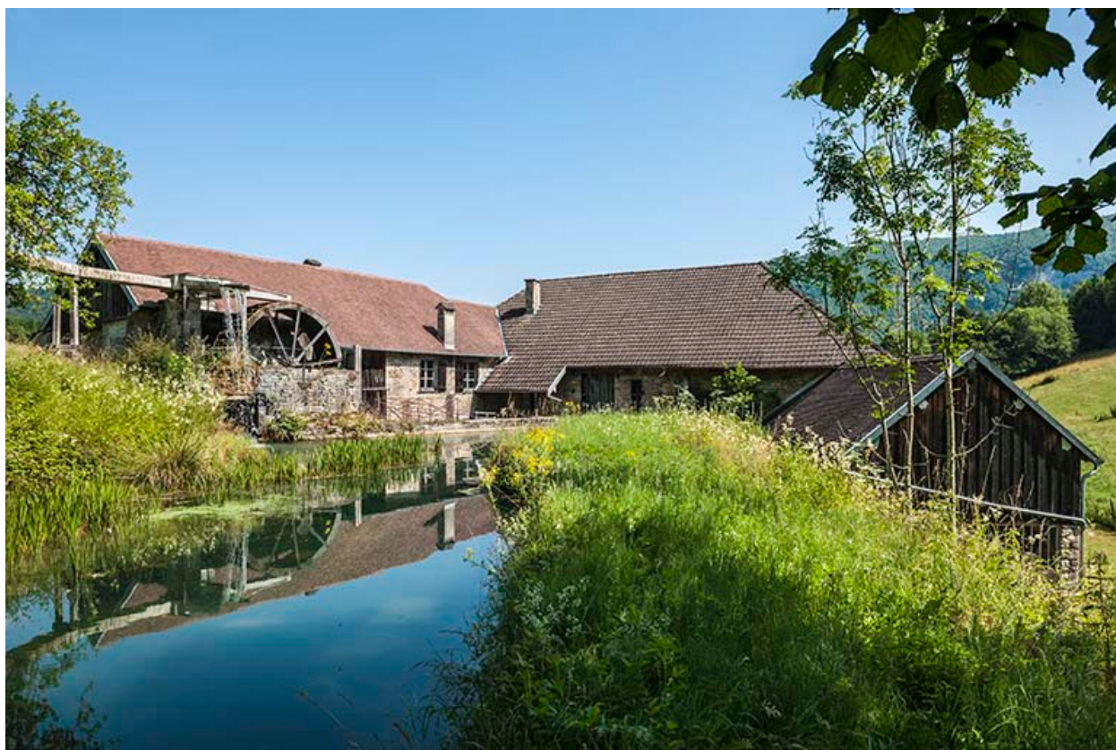
La taillanderie vue depuis le canal d'amenée.
