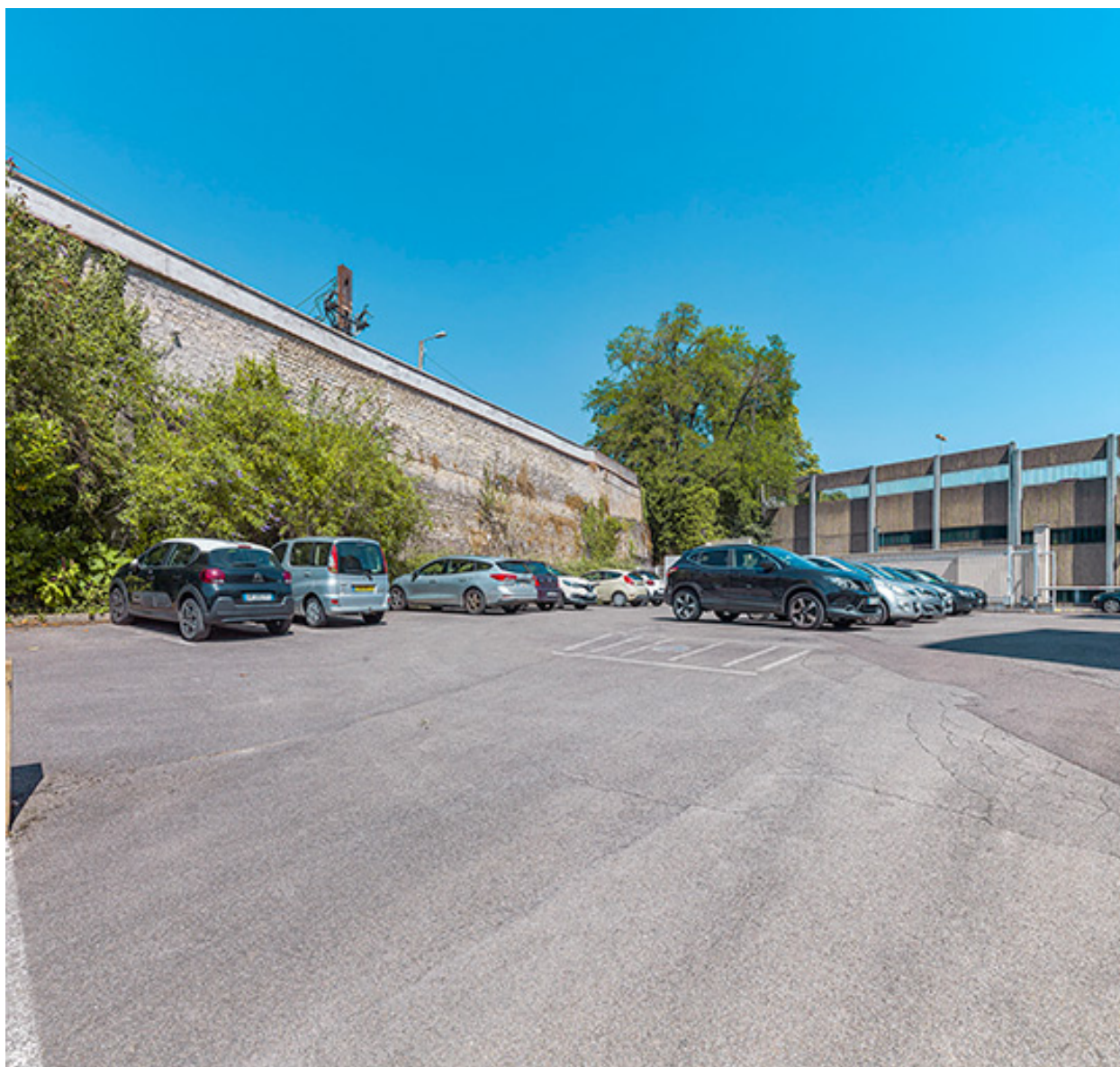
Elévation du rempart de la Miséricorde.
