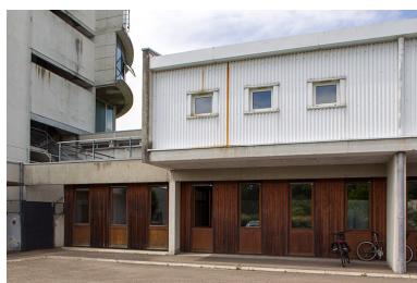
Entrée au rez-de-chaussée du bâtiment "agencement". Phot. Sonia Dourlot IVR43_20142500820NUC2A
