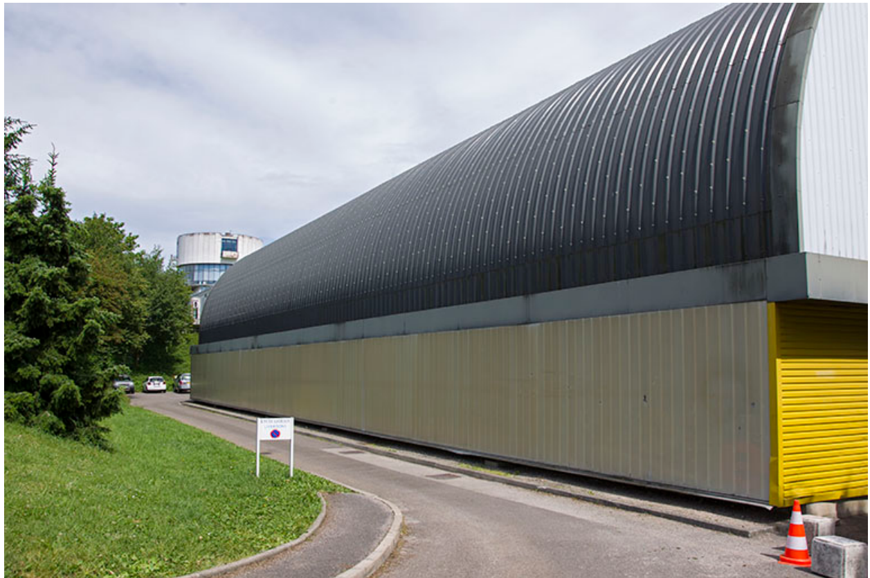
Vue postérieure du gymnase, angle nord-ouest.
