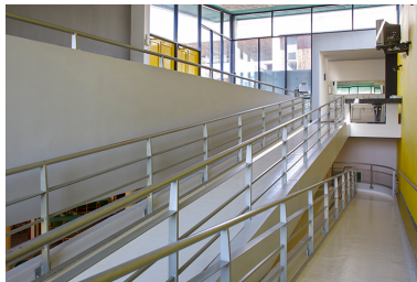
Détail de circulation intérieure. Phot. Sonia Dourlot IVR43_20142500852NUC2A
