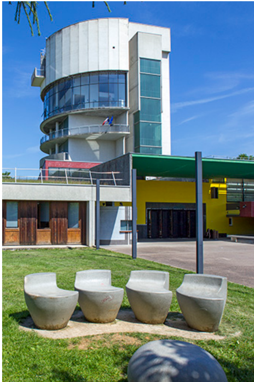
L'entrée et la tour depuis le sud-ouest.
