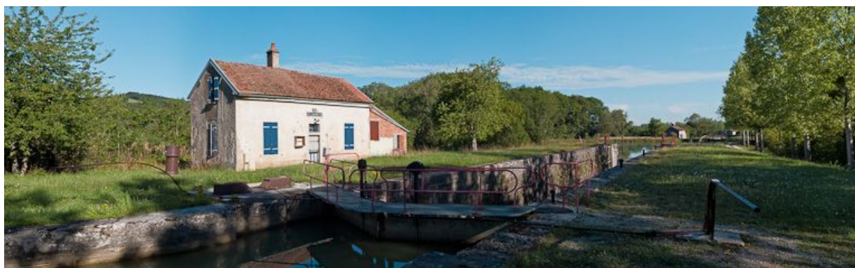
Vue d'ensemble du site d'écluse.
