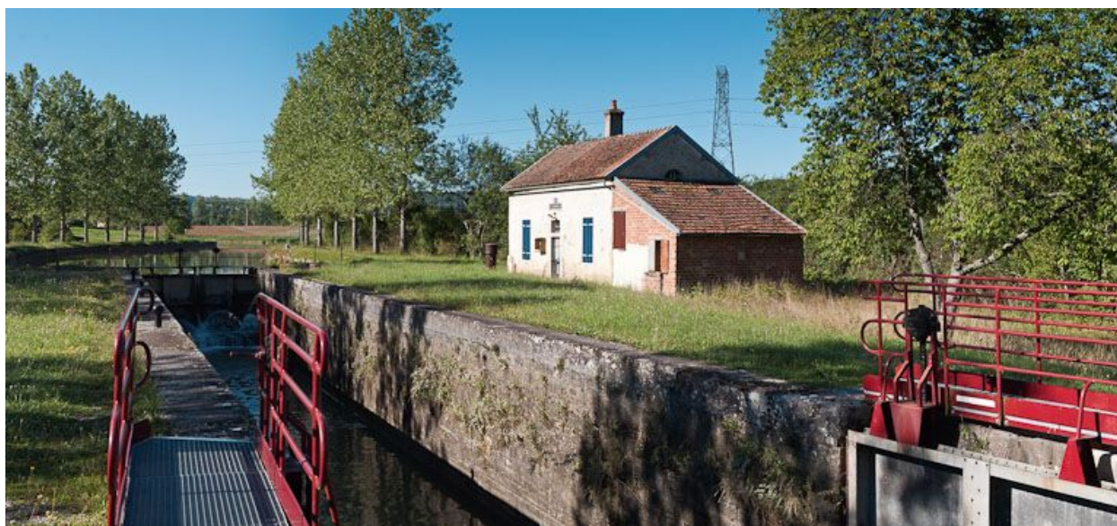
Vue d'ensemble du site d'écluse.
