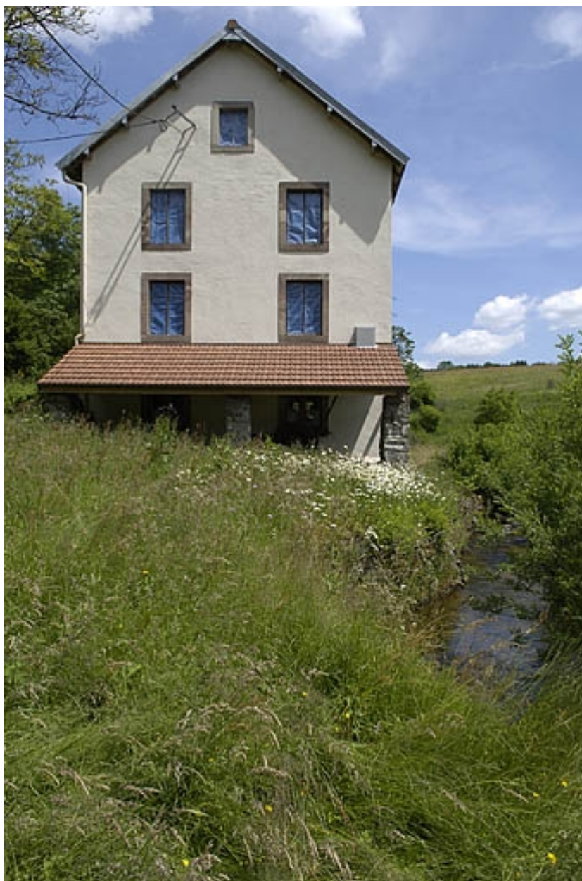
Façade nord-ouest et appentis abritant la turbine.
