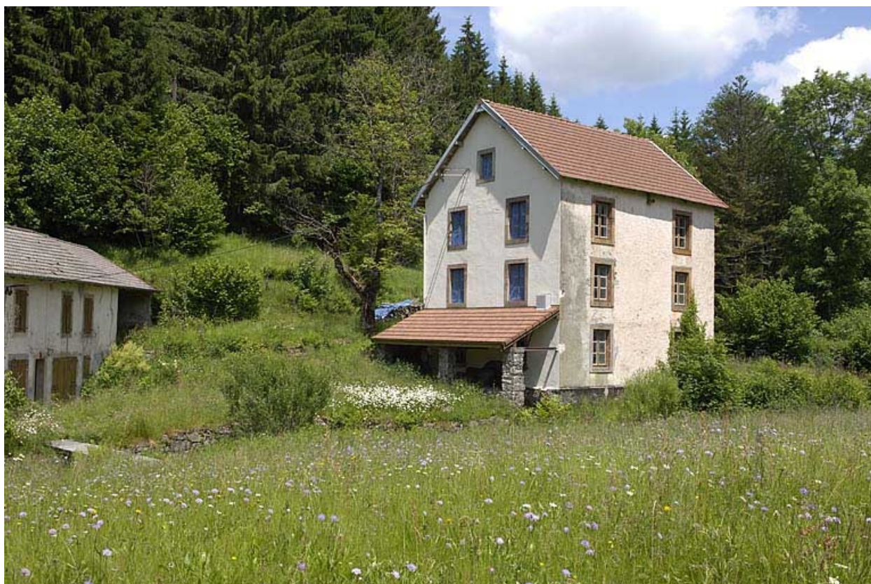
Le moulin vu depuis l'ouest.
