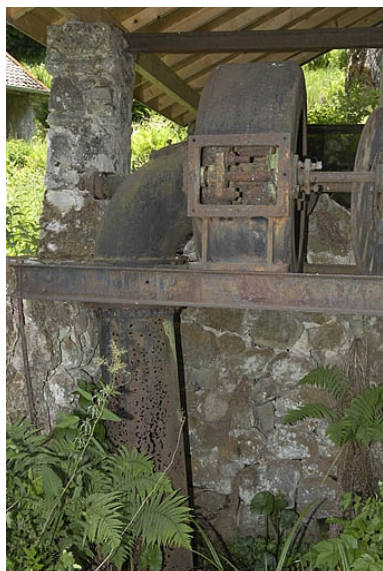
Turbine horizontale et sa conduite d'évacuation. Phot. Jérôme Mongreville IVR43_20057000267NUCA
