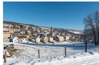
Vue d'ensemble depuis le sud-ouest (façades postérieure et latérale droite), en hiver. Phot. Sonia Dourlot IVR43_20192500500NUC4A
