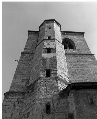
La tour-clocher : 2ème et 3ème niveaux. Phot. Yves Sancey IVR43_19792500197X
