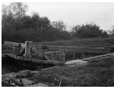
Portes en bois de l'écluse. Phot. non renseigné IVR26_19755800794V
