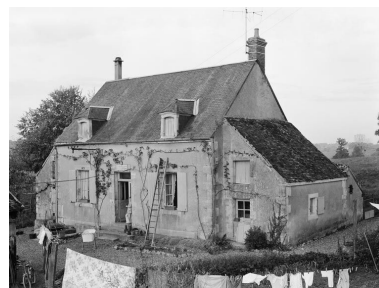
Vue d'ensemble de la maison éclusière. Phot. non renseigné IVR26_19755800797V
