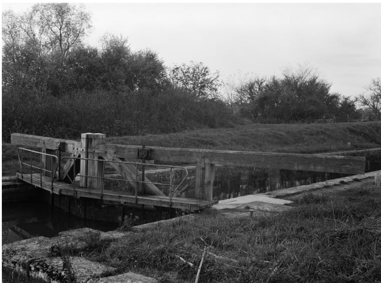
Portes en bois de l'écluse.
