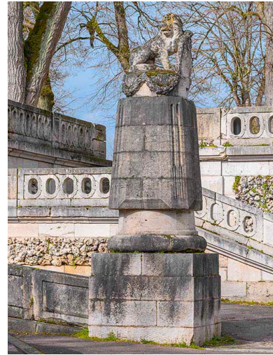
Piédestal surmonté par un des lions. Phot. Thierry Kuntz IVR26_20242100117NUC4A
