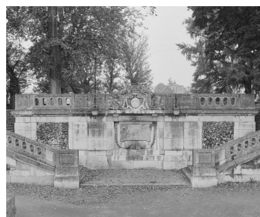
Vue de détail de l'escalier, de face (1988). Phot. Jean-Luc Duthu IVR26_19882103197X
