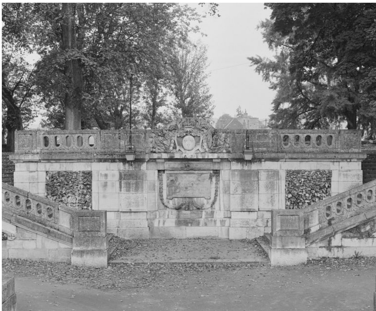
Vue de détail de l'escalier, de face (1988).
