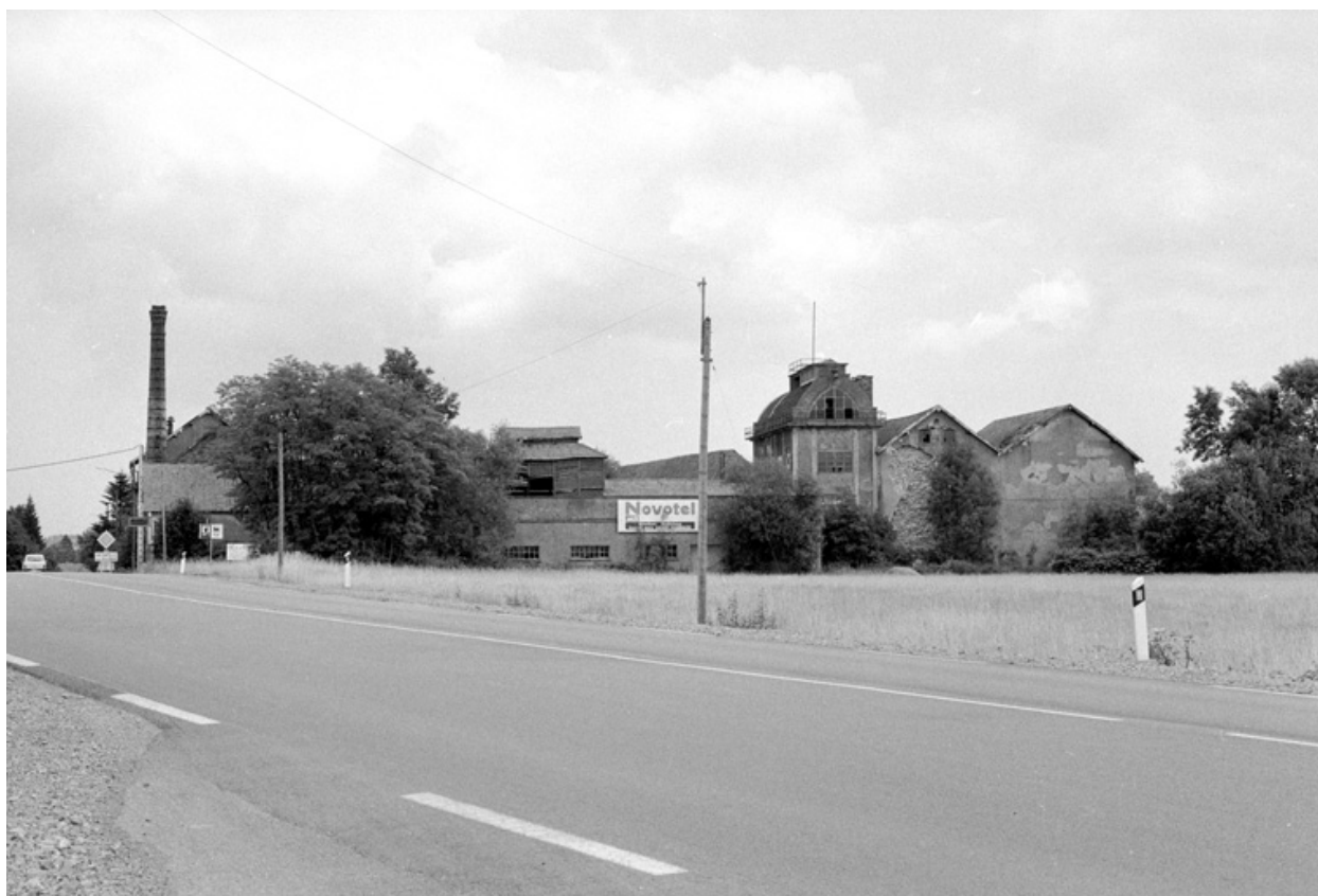
Vue d'ensemble en 1980.SRI. Enquête régionale sur les bâtiments industriels (1979-1981).
