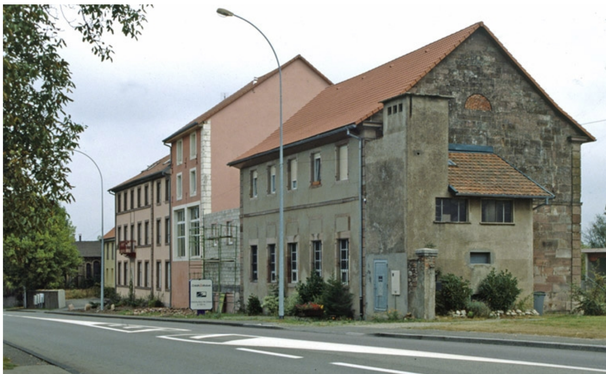
Ateliers de fabrication et logements depuis l'ouest.
