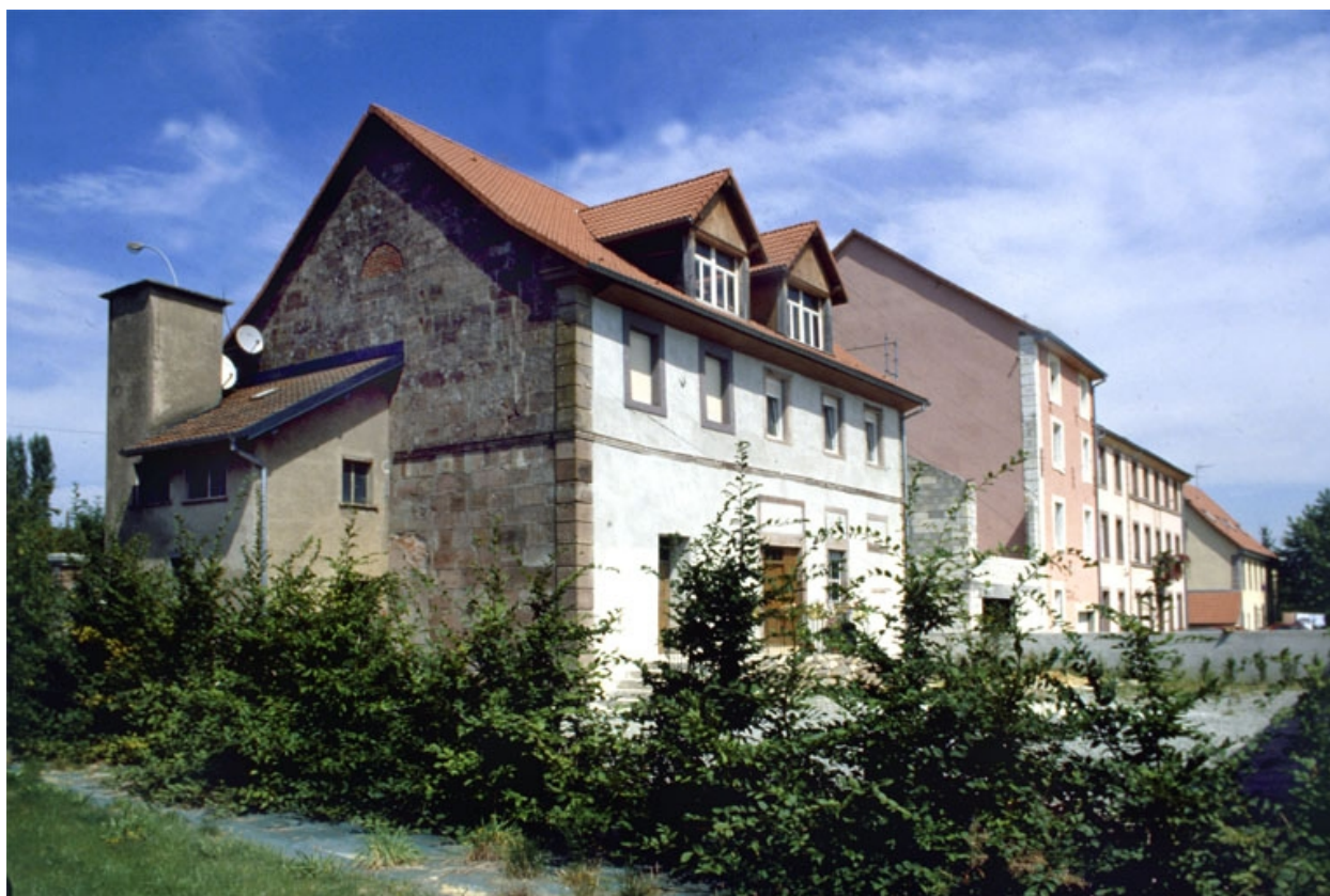
Façade postérieure des ateliers de fabrication.
