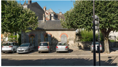
L'ancienne maison éclusière, de face. Phot. Pierre-Marie Barbe-Richaud IVR26_20135800462NUC4AQ
