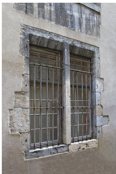
Logis principal : détail d'une baie. Phot. Yves Sancey IVR43_20102500926NUC2A
