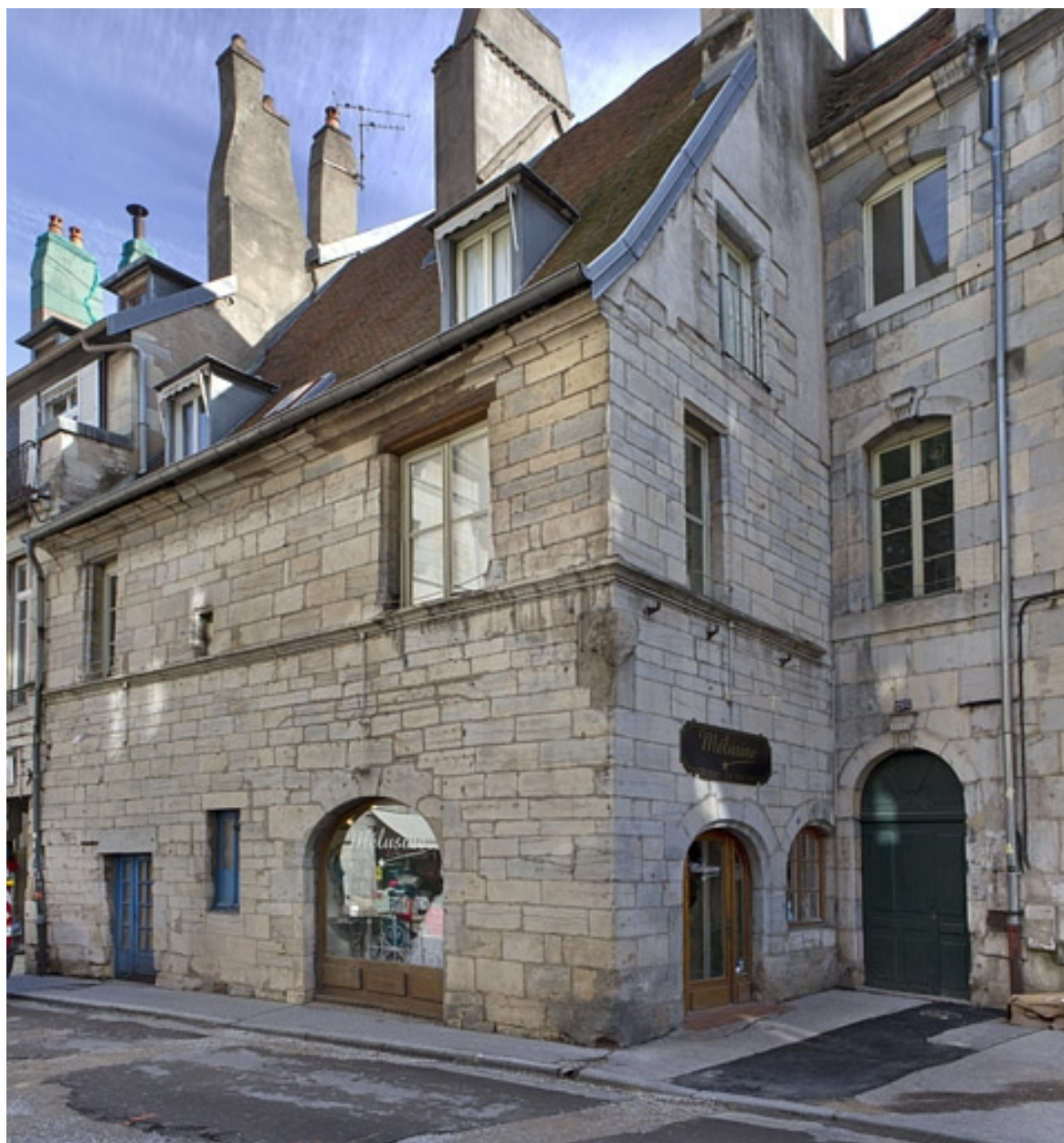
Logis principal : vue d'ensemble depuis la rue.
