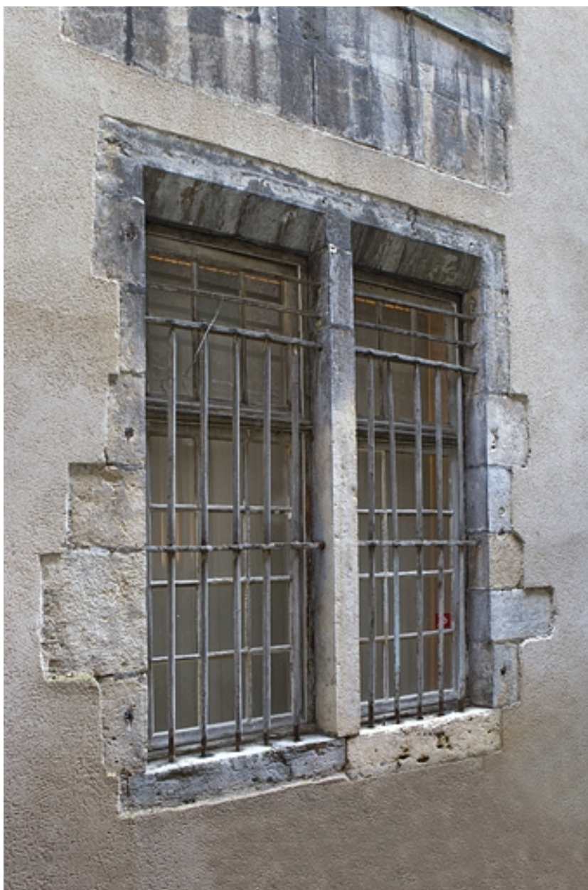
Logis principal : détail d'une baie.
