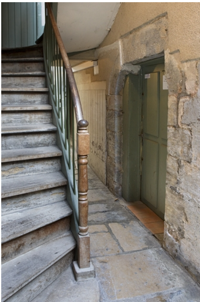
Logis principal : détail de l'escalier.
