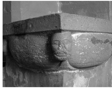
Détail. Phot. Yves Sancey IVR43_19753900896X
