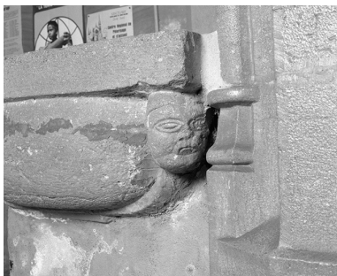
Détail. Phot. Yves Sancey IVR43_19753900897X
