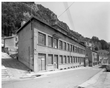
Vue d'ensemble. Phot. Jérôme Mongreville IVR43_19923900794V
