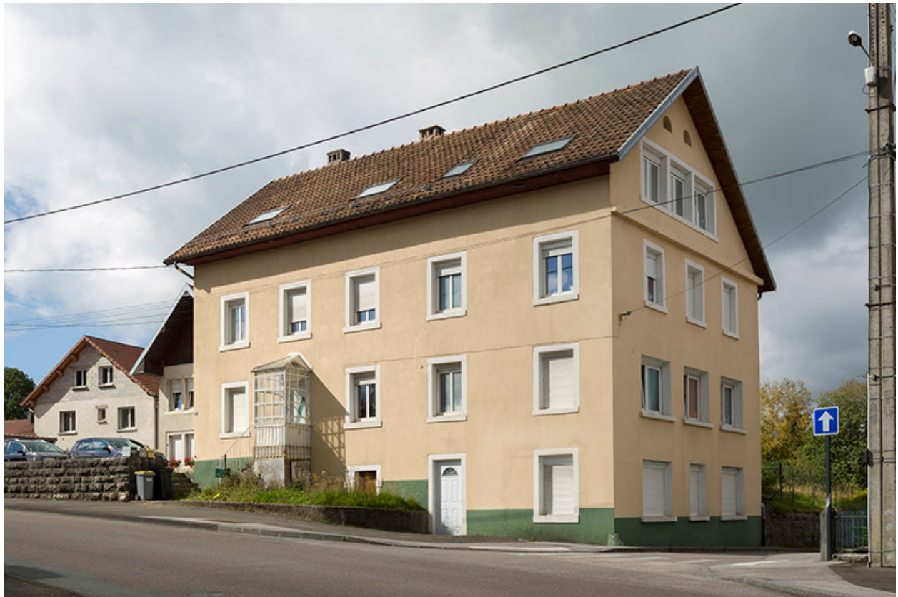
Façades antérieure et latérale droite.
