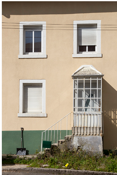
Façade antérieure : entrée.
