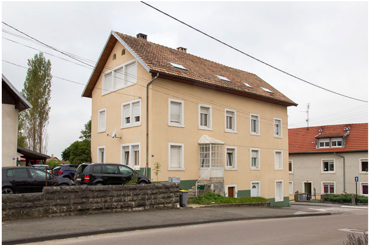
Façades antérieure et latérale gauche.
