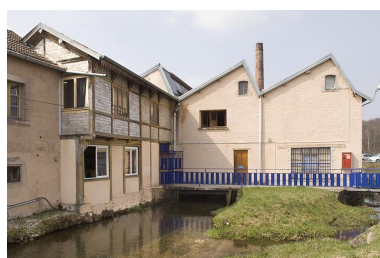
Conciergerie, bureau et atelier depuis l'avenue du Breuchin. Phot. Jérôme Mongreville IVR43_20097000475NUC2A
