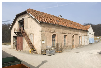
Moulin d'aval. Vue de trois quarts.
