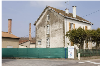
Logement patronal depuis le sud. Phot. Jérôme Mongreville IVR43_20097000488NUC2A
