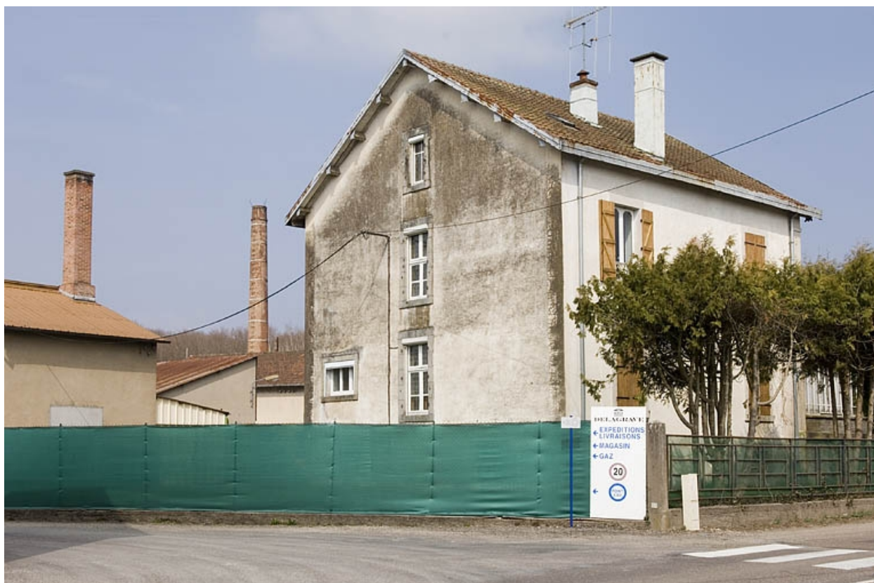
Logement patronal depuis le sud.
