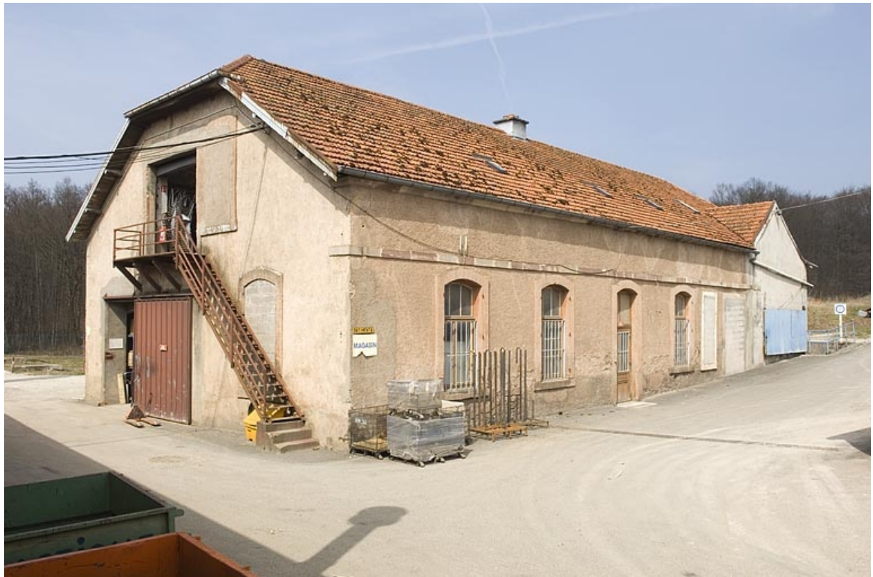
Moulin d'aval. Vue de trois quarts.
