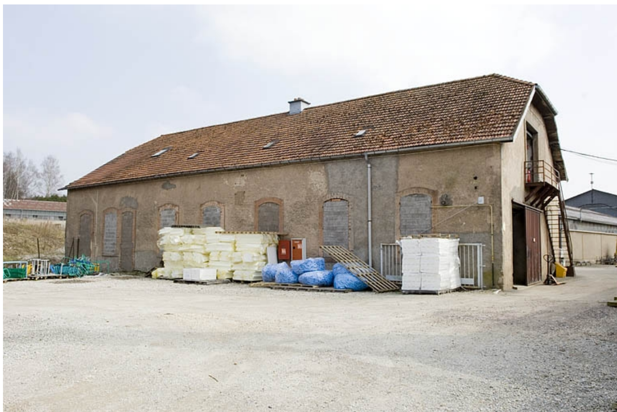
Moulin d'aval. Vue de trois quarts arrière.
