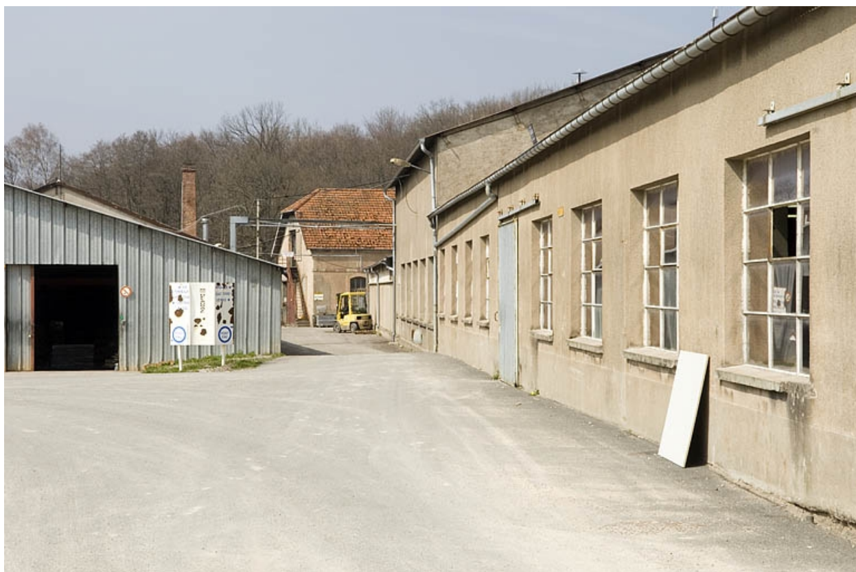
Façade ouest d'un atelier de menuiserie.
