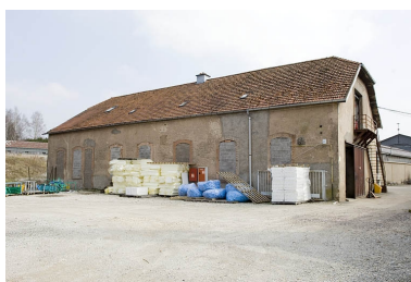
Moulin d'aval. Vue de trois quarts arrière.
