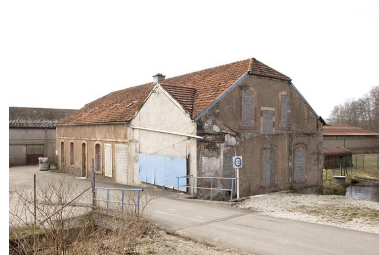
Moulin d'aval. Vue depuis l'est.
