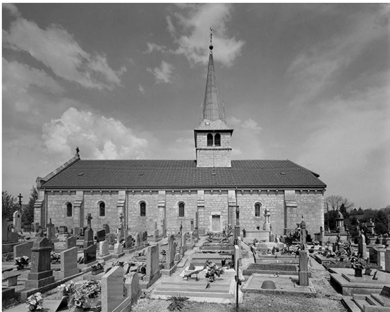
Façade latérale droite.
