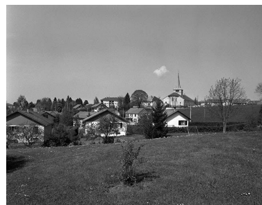
Vue de situation. Phot. Jérôme Mongreville IVR43_20003900625X
