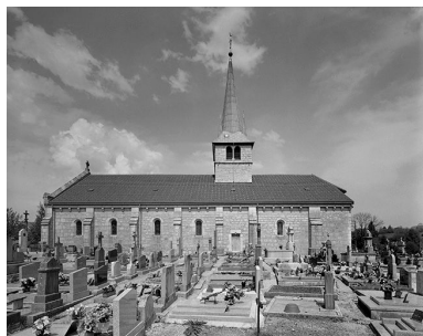
Façade latérale droite. Phot. Jérôme Mongreville IVR43_20003900632V
