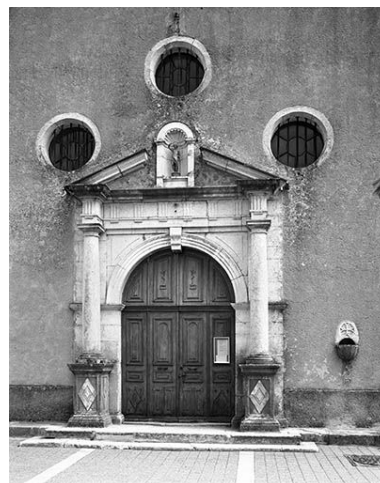
Le porche d'entrée. Phot. Jérôme Mongreville IVR43_20003900629X
