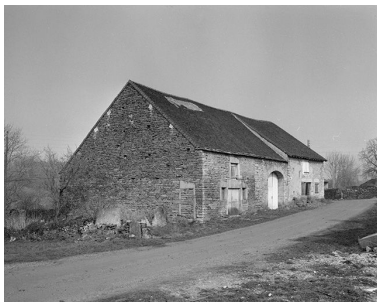
Façade antérieure et pignon gauche. Phot. Jérôme Mongreville IVR43_19853900083X
