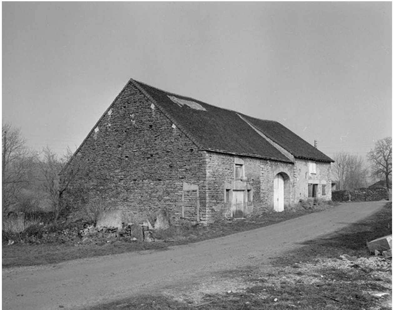
Façade antérieure et pignon gauche.
