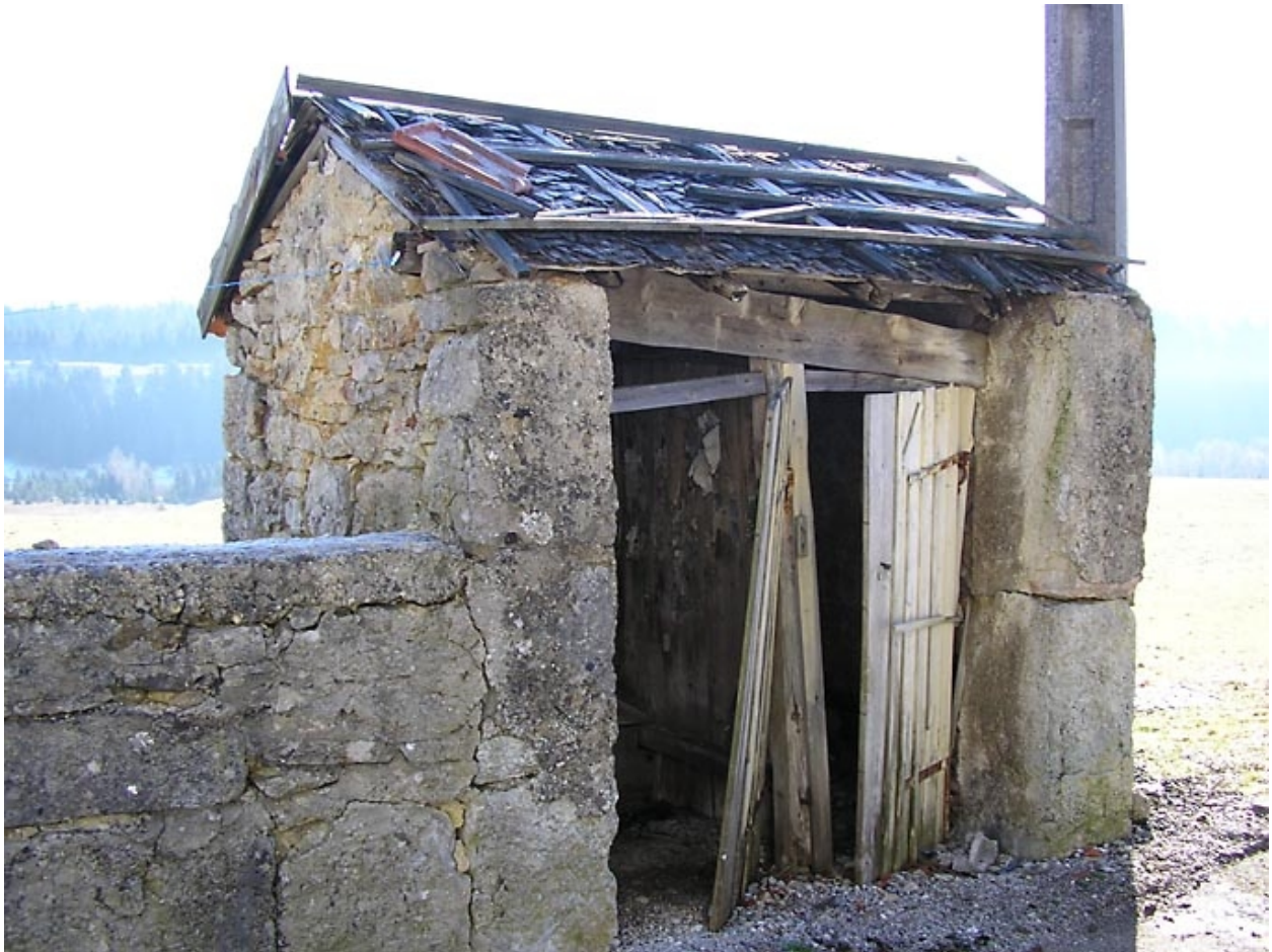
Les toilettes extérieures.
