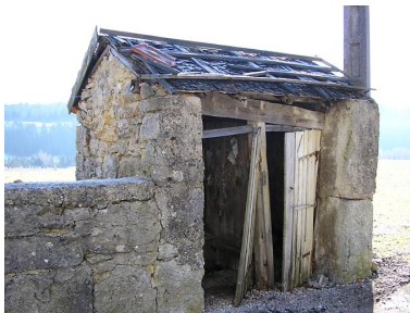
Les toilettes extérieures. Phot. Marie-Pierre Reynet IVR43_20083900487NUC1A
