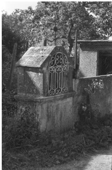
Vue générale. Phot. Guy Forestier IVR43_19743900599Z
