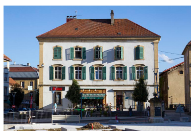
Façade antérieure (2013). Phot. Yves Sancey IVR43_20132502259NUC2A
