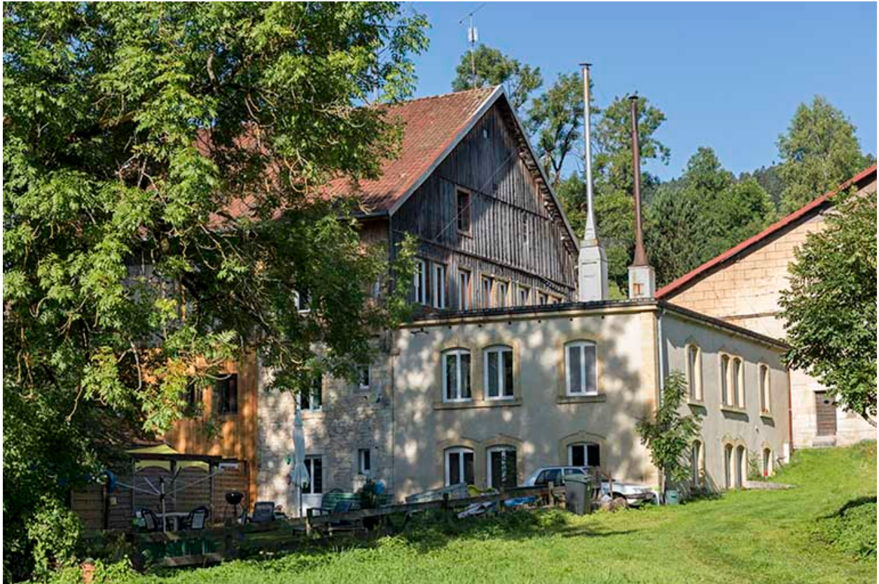
Extension nord, vue de l'est.
