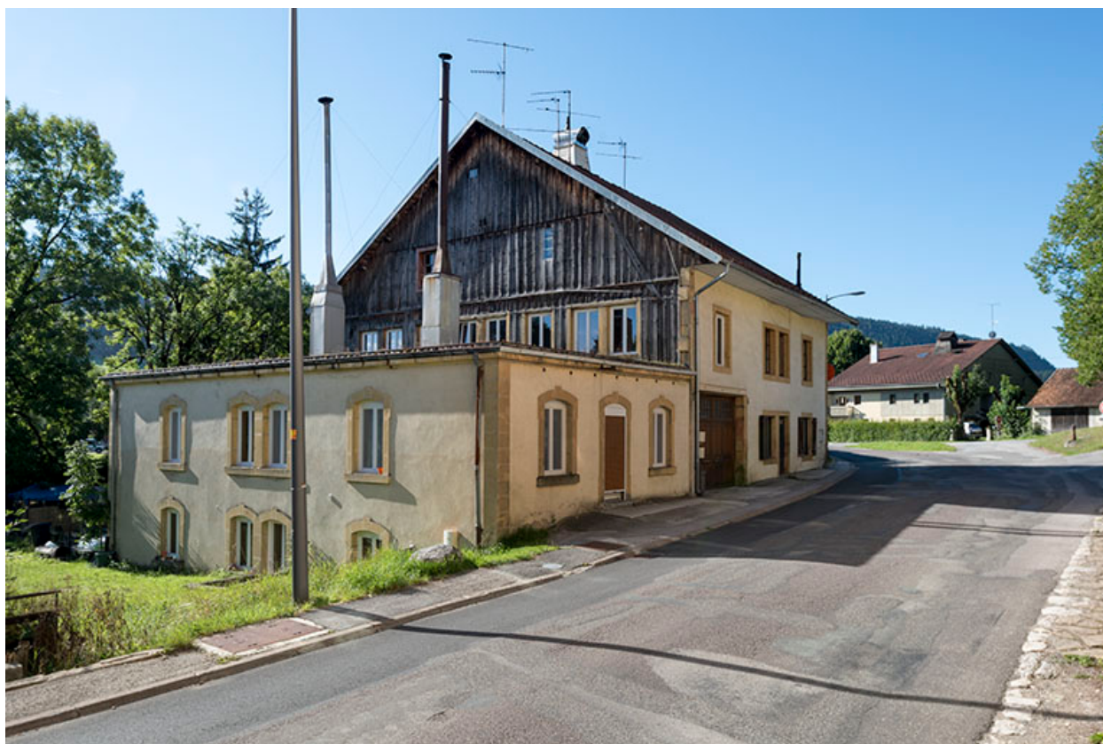
Façades antérieure et latérale gauche.
