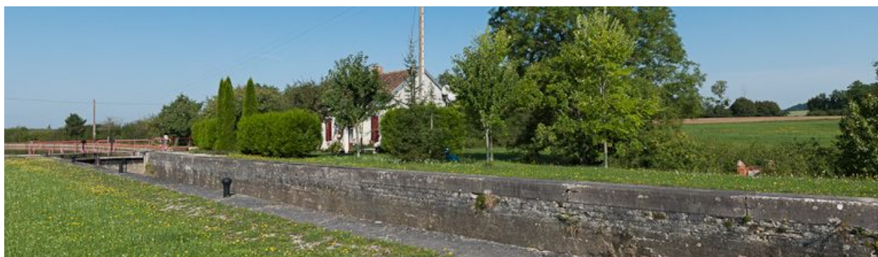
Vue d'ensemble du site d'écluse.
