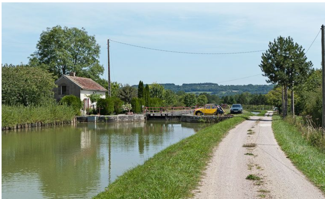
Vue du site d'écluse depuis l'amont.
