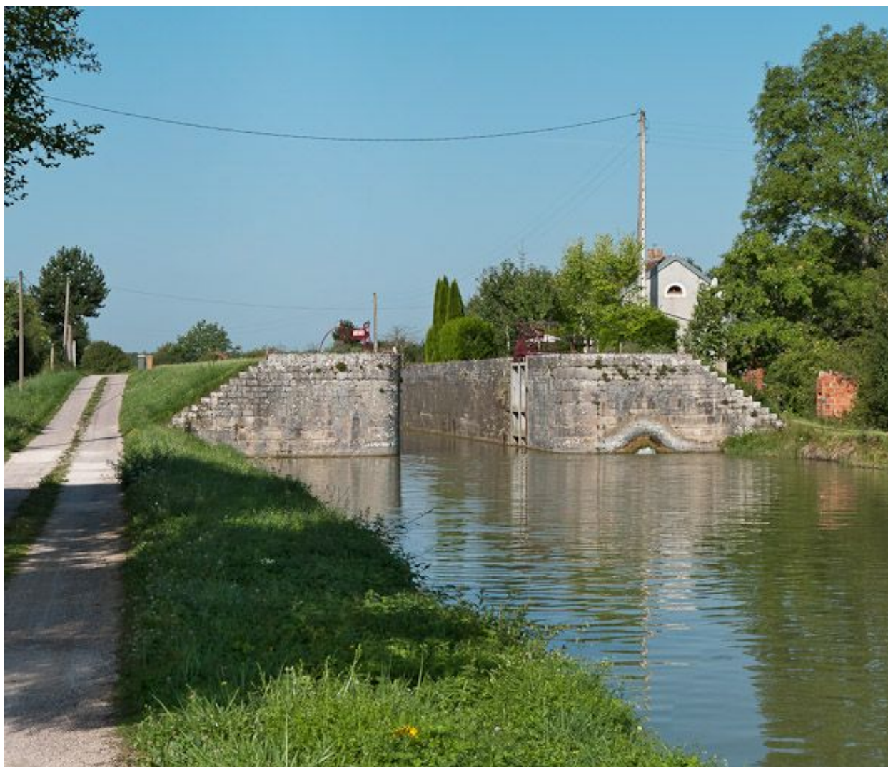
Vue du site d'écluse depuis l'aval.
