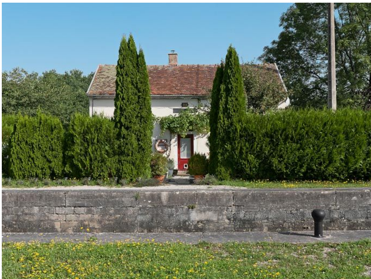
Vue de face de la maison éclusière.
