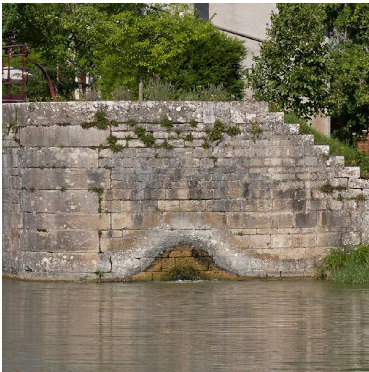
Détail de l'aqueduc Freycinet.
