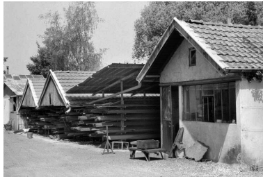
Ancienne remise et entrepôts industriels. Phot. Laurent Poupard IVR43_19893901242Z
