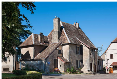
Vue générale sud Phot. Jérôme Mongreville IVR43_20137000296NUCA
