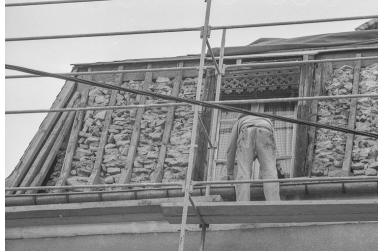
Les combles. Phot. Bernard Lardière IVR43_19797000196Z
