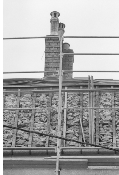
Réfection de la toiture. Phot. Bernard Lardière IVR43_19797000197Z
