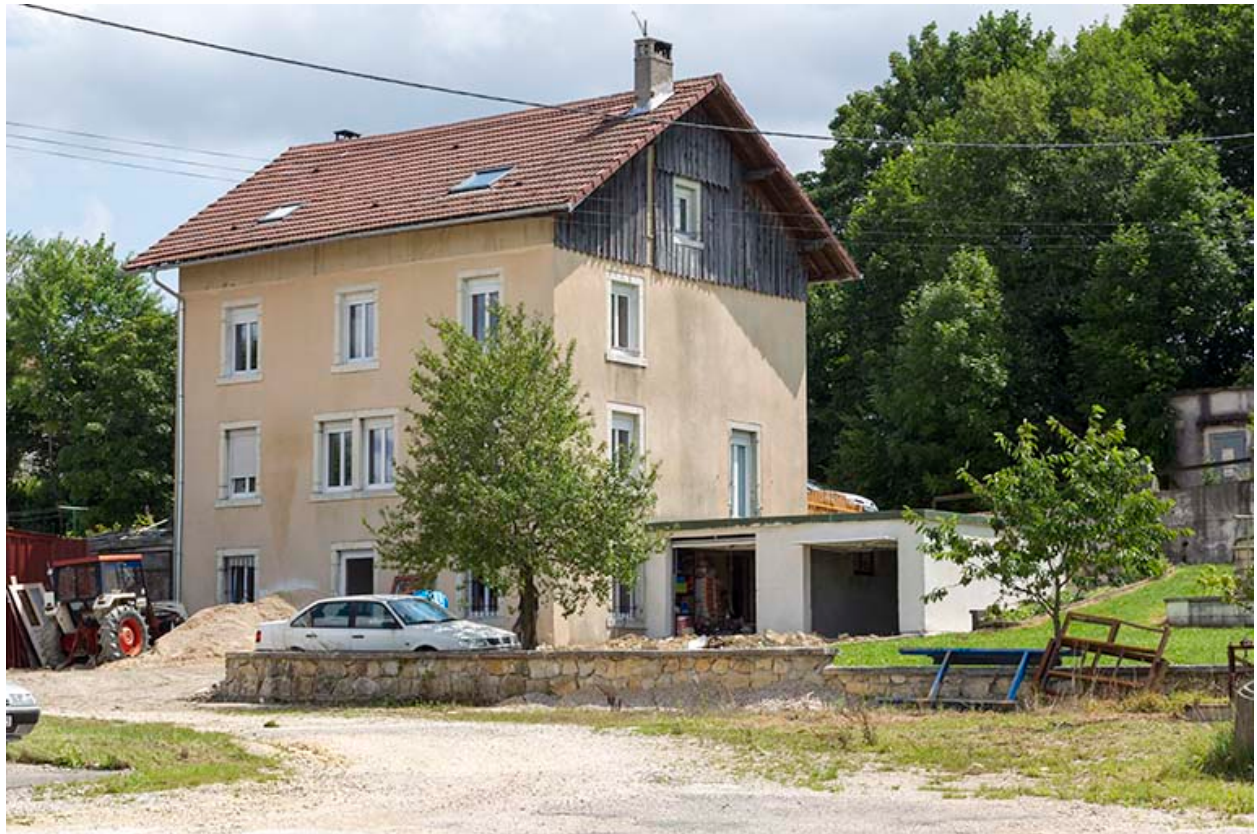
Façades postérieure et latérale gauche.
