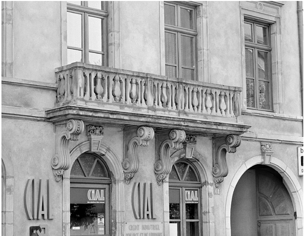
Façade sur rue. Détail du balcon.
