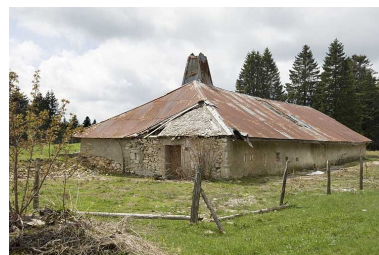
Façade latérale droite
