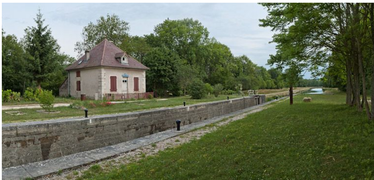
Vue d'ensemble du site d'écluse.
