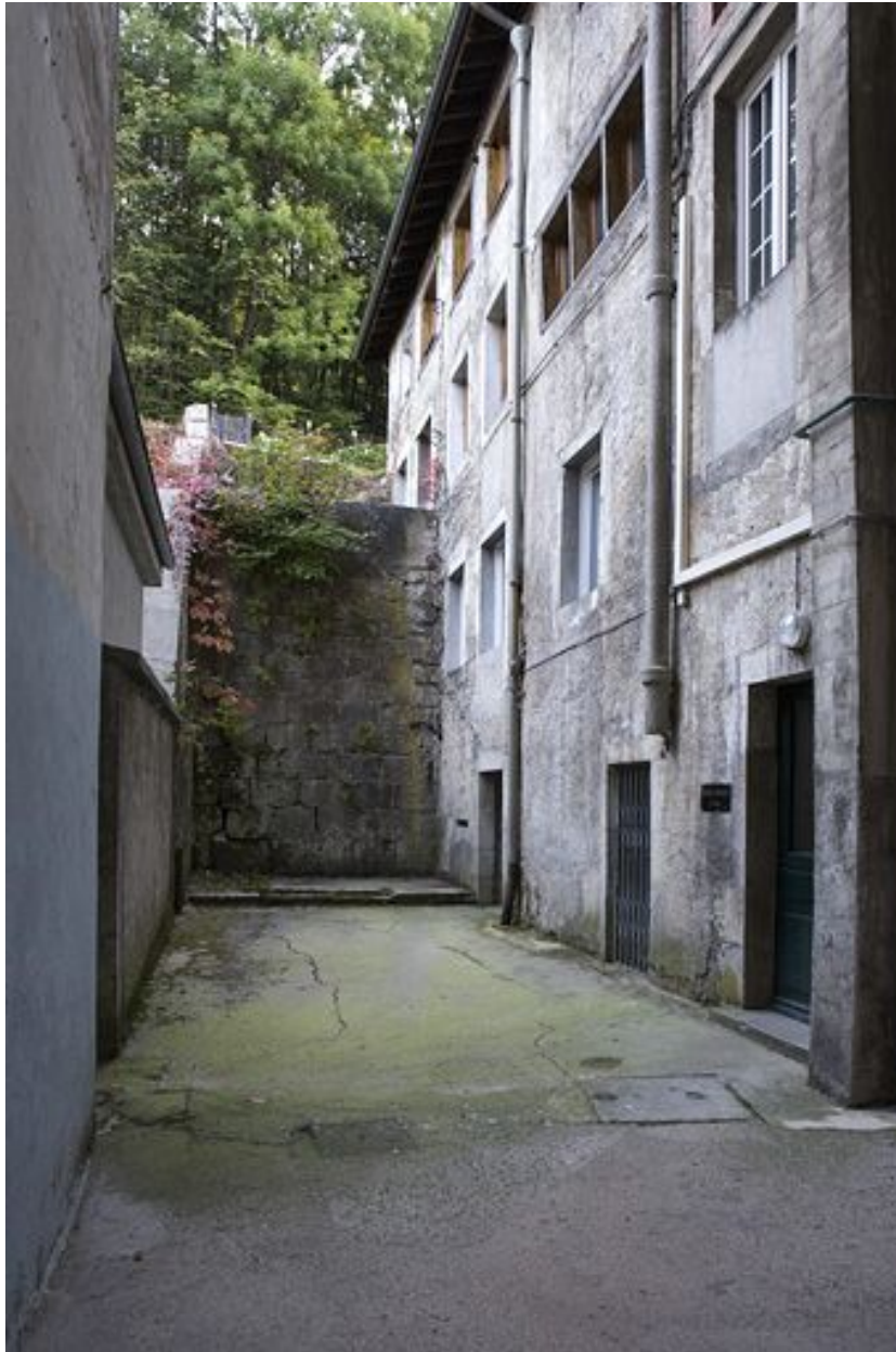
Cour, ancien atelier et mur de soutènement.
