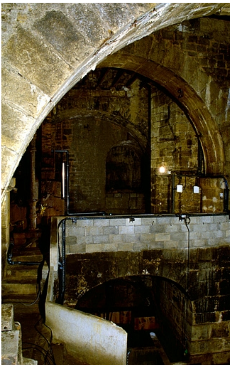
Vue d'ensemble depuis l'angle sud-ouest.
