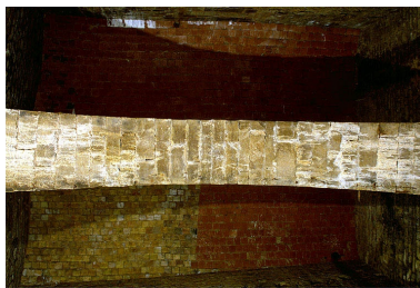
Voûtes en berceau segmentaire de briques du puits à Muire. Phot. Yves Sancey IVR43_19973902032ZA
