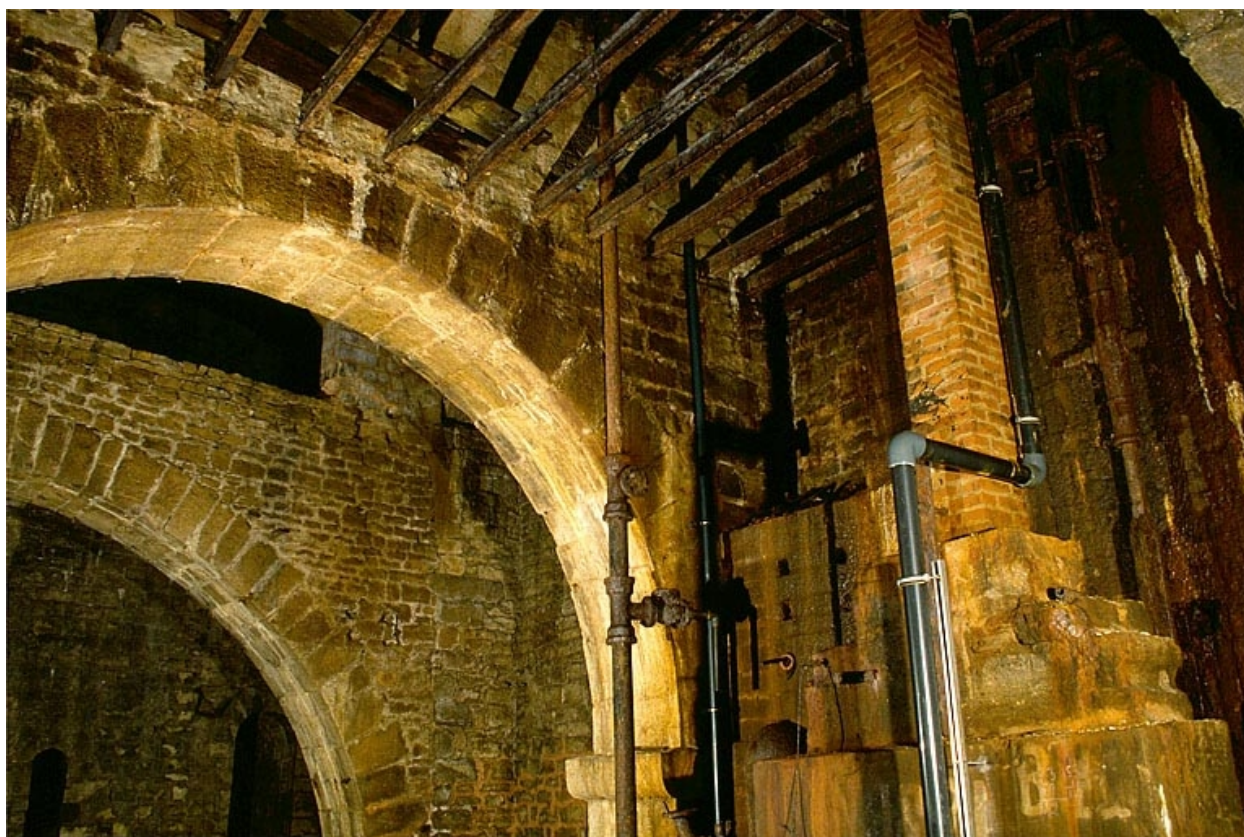
Parties supérieures du puits à Muire.
