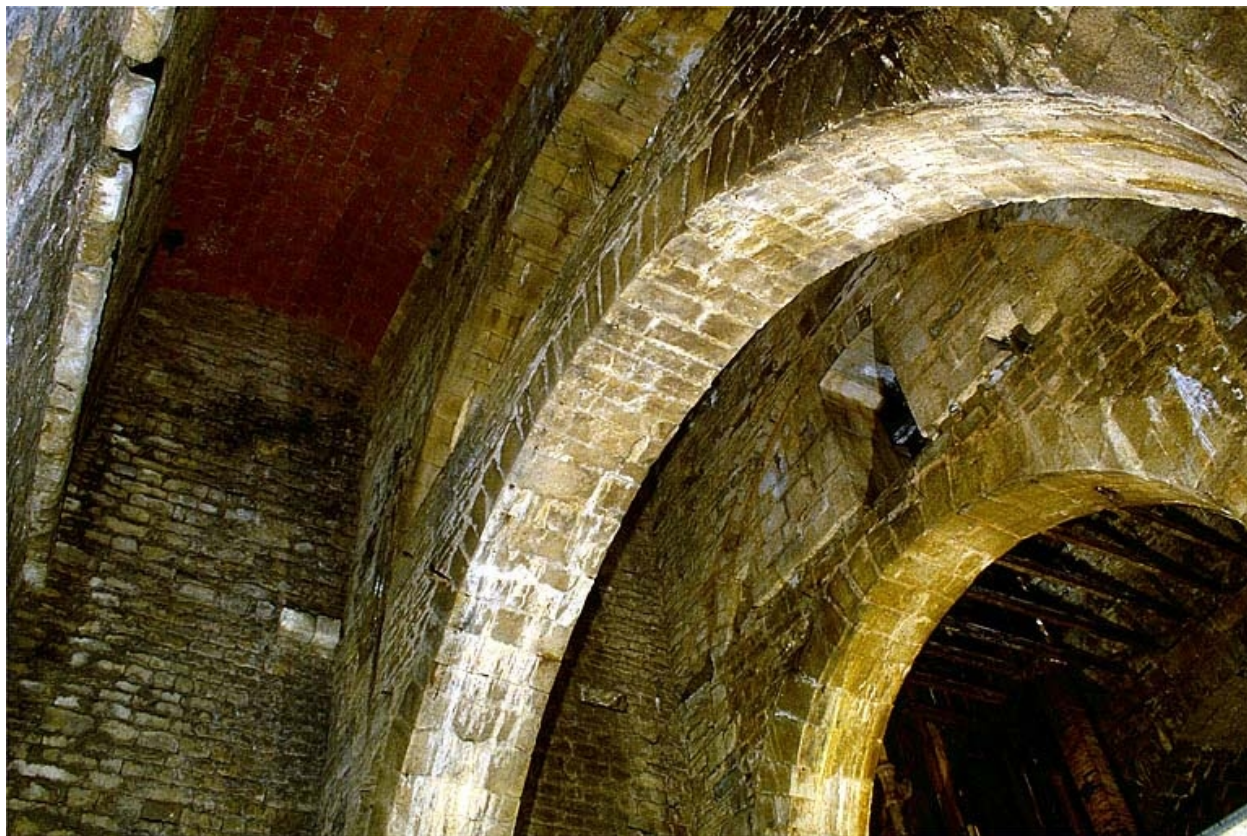
Arcs-diaphragmes et voûtement du puits.
