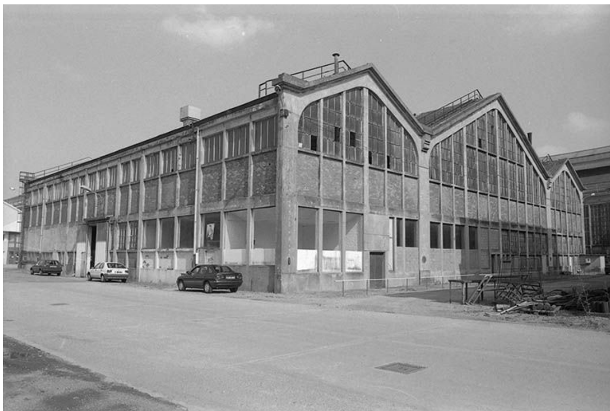
Magasin, vestiaires et douches vus de l'ouest.
