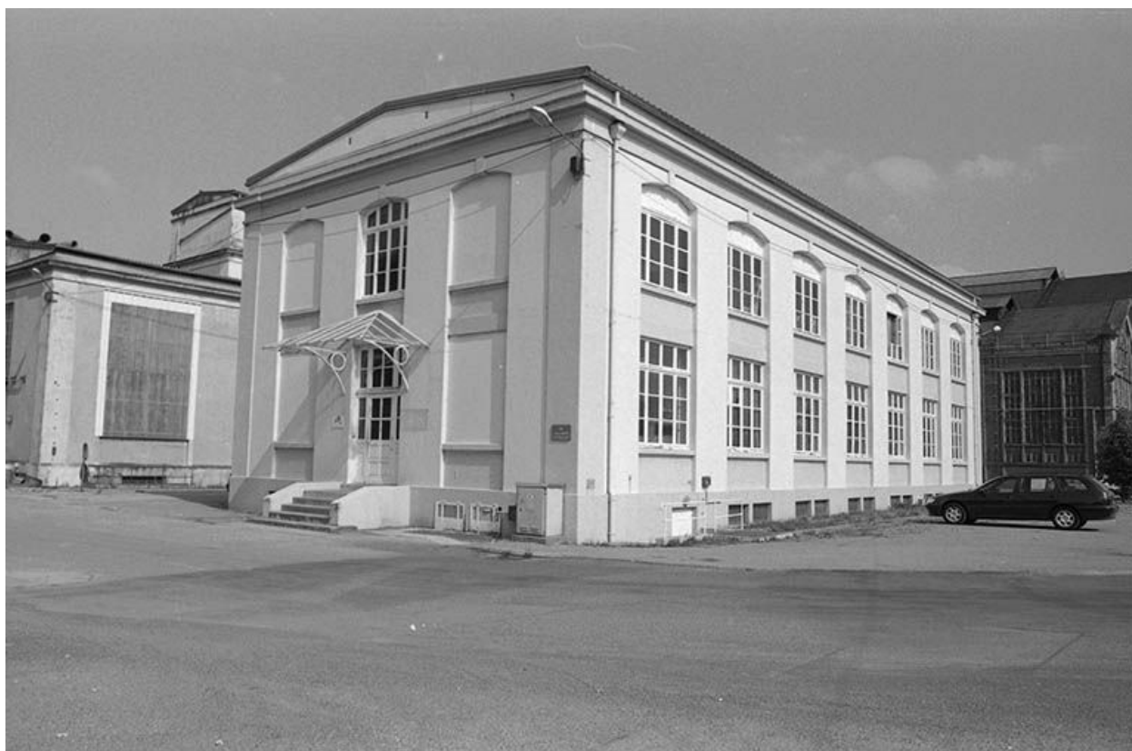
Bureaux généraux, vus de l'ouest.
