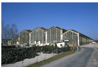
Elévation sud-ouest de la grande halle. Phot. Jean-Luc Duthu IVR26_20007100130ZA
