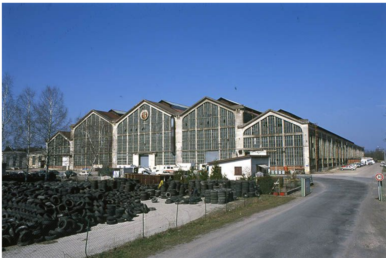
Elévation sud-ouest de la grande halle.
