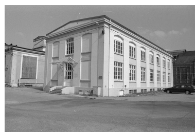
Bureaux généraux, vus de l'ouest.
