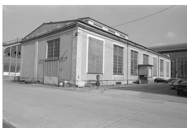
Sous-station électrique, vue de l'ouest.
