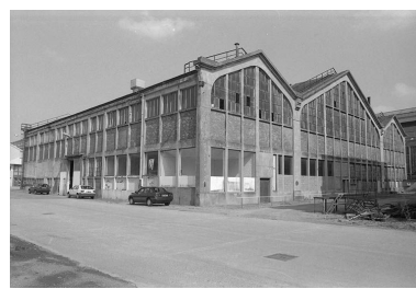
Magasin, vestiaires et douches vus de l'ouest.
