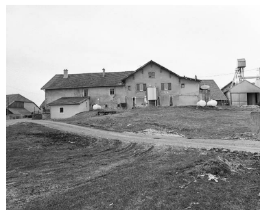
Façade postérieure. Phot. Yves Sancey IVR43_19983900011X
