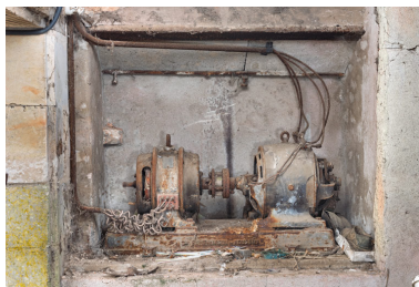
Moteur asynchrone de la Cie française Thomson-Houston (Paris), près de la cabine de projection. Phot. Pierre-Marie Barbe-Richaud IVR26_20245800332NUC4A
