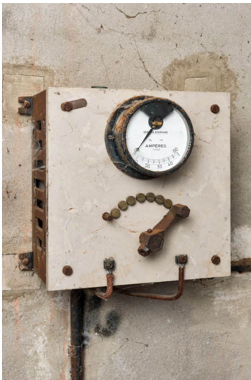
Cabine de projection : un rhéostat.
