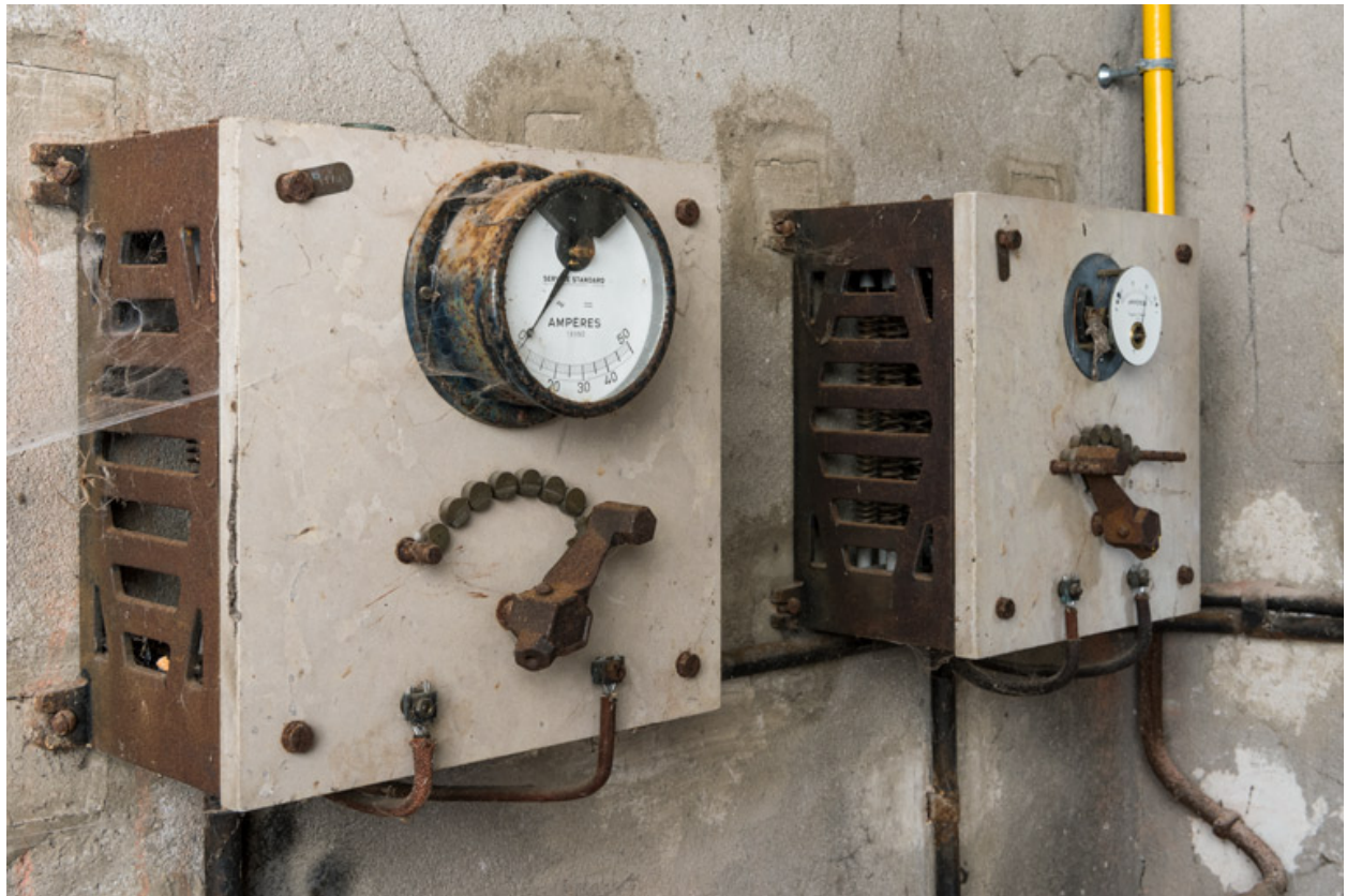
Cabine de projection : rhéostats.
