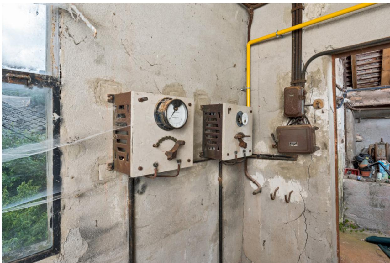
Cabine de projection : rhéostats.
