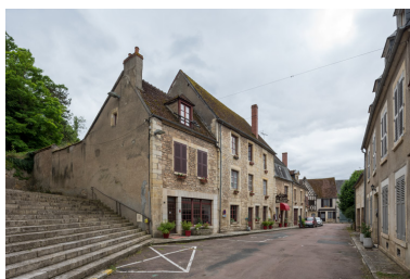
Vue d'ensemble de l'hôtel- restaurant du Grand Monarque. Phot. Pierre-Marie Barbe-Richaud IVR26_20245800326NUC4A
