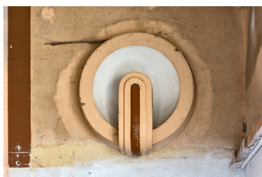
Luminaire d'applique. Phot. Pierre-Marie Barbe-Richaud IVR26_20245800335NUC4A
