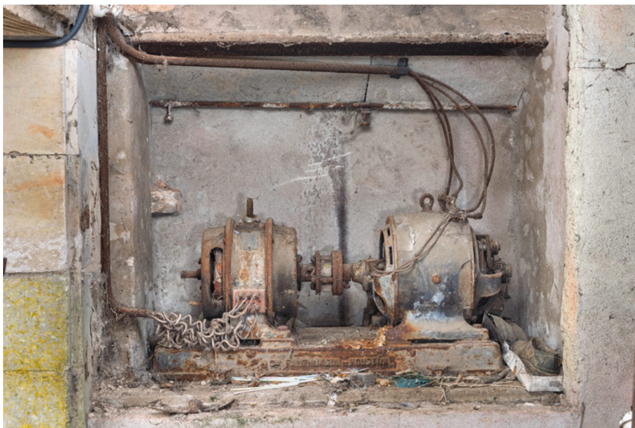
Moteur asynchrone de la Cie française Thomson-Houston (Paris), près de la cabine de projection.
