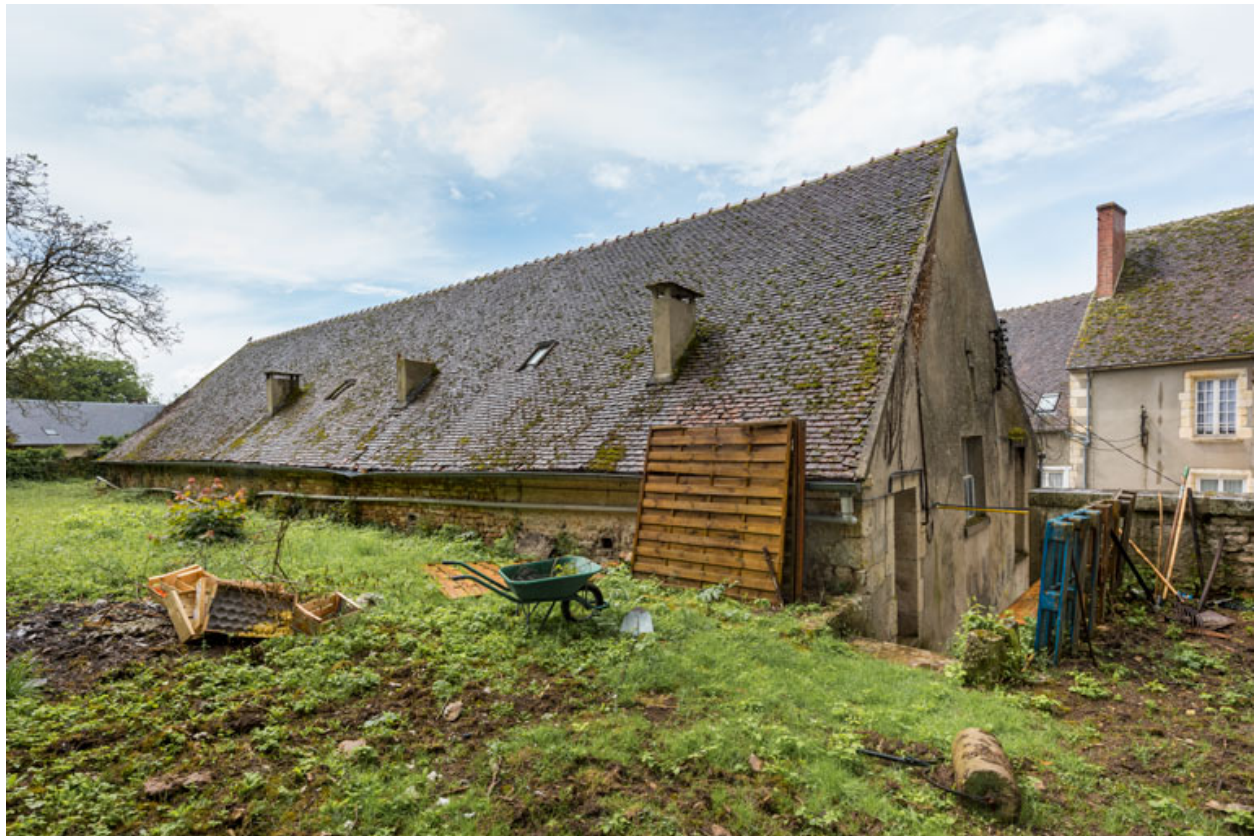
Façades postérieure et latérale gauche.
