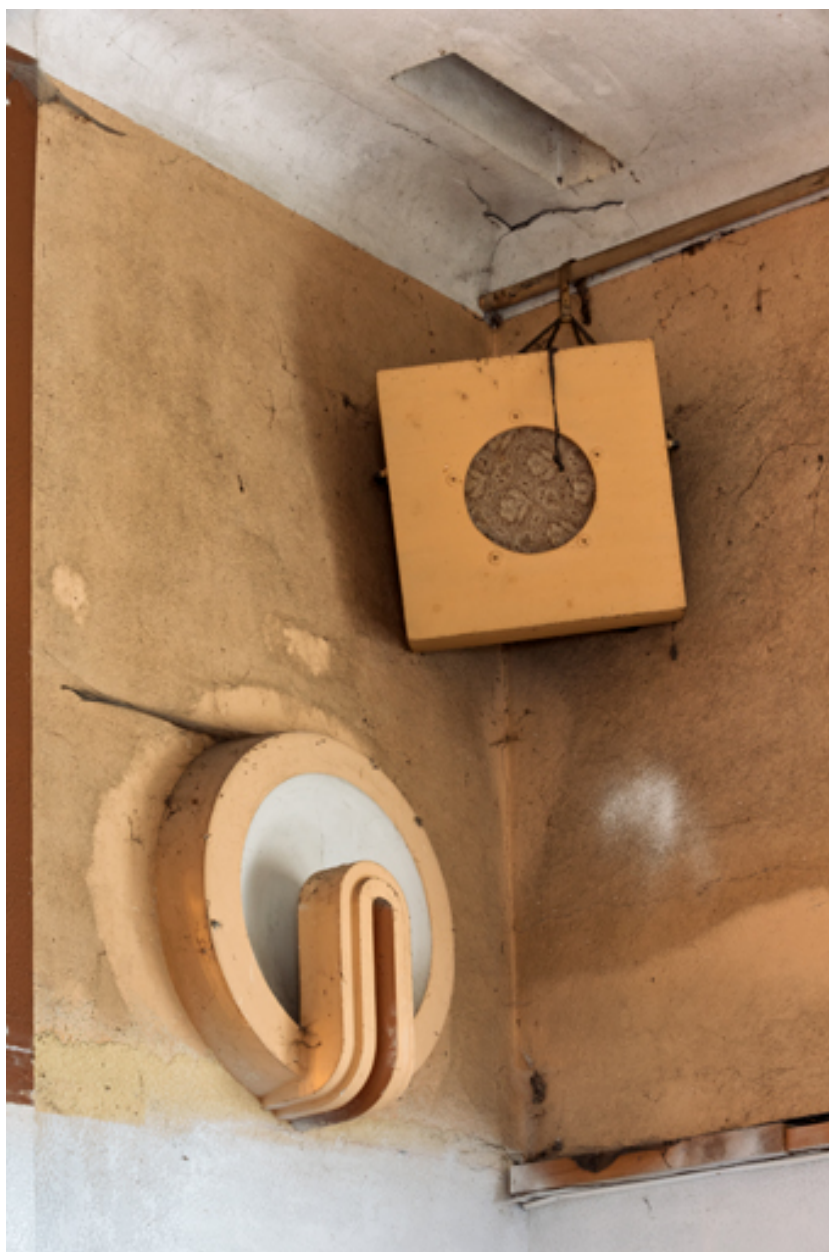
Luminaire d'applique et haut-parleur.
