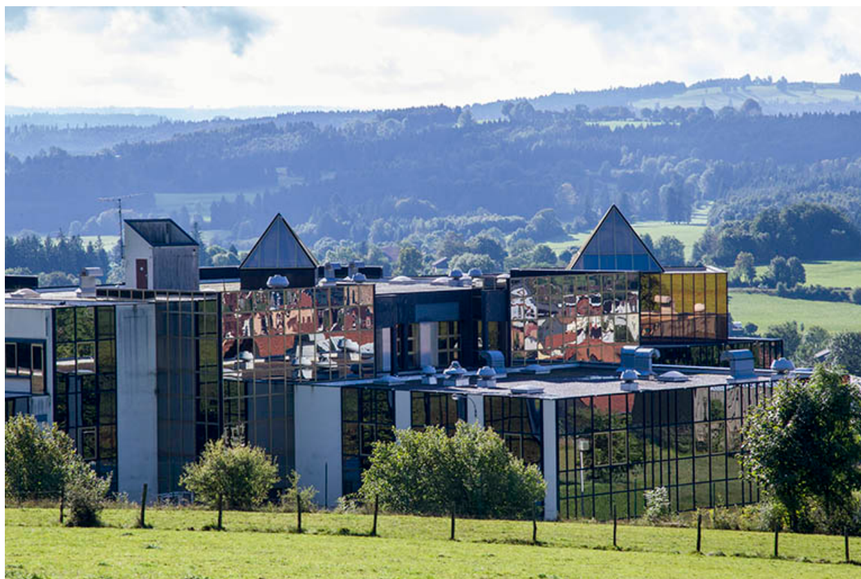
Emboîtement de volumes, vu du nord-ouest.
