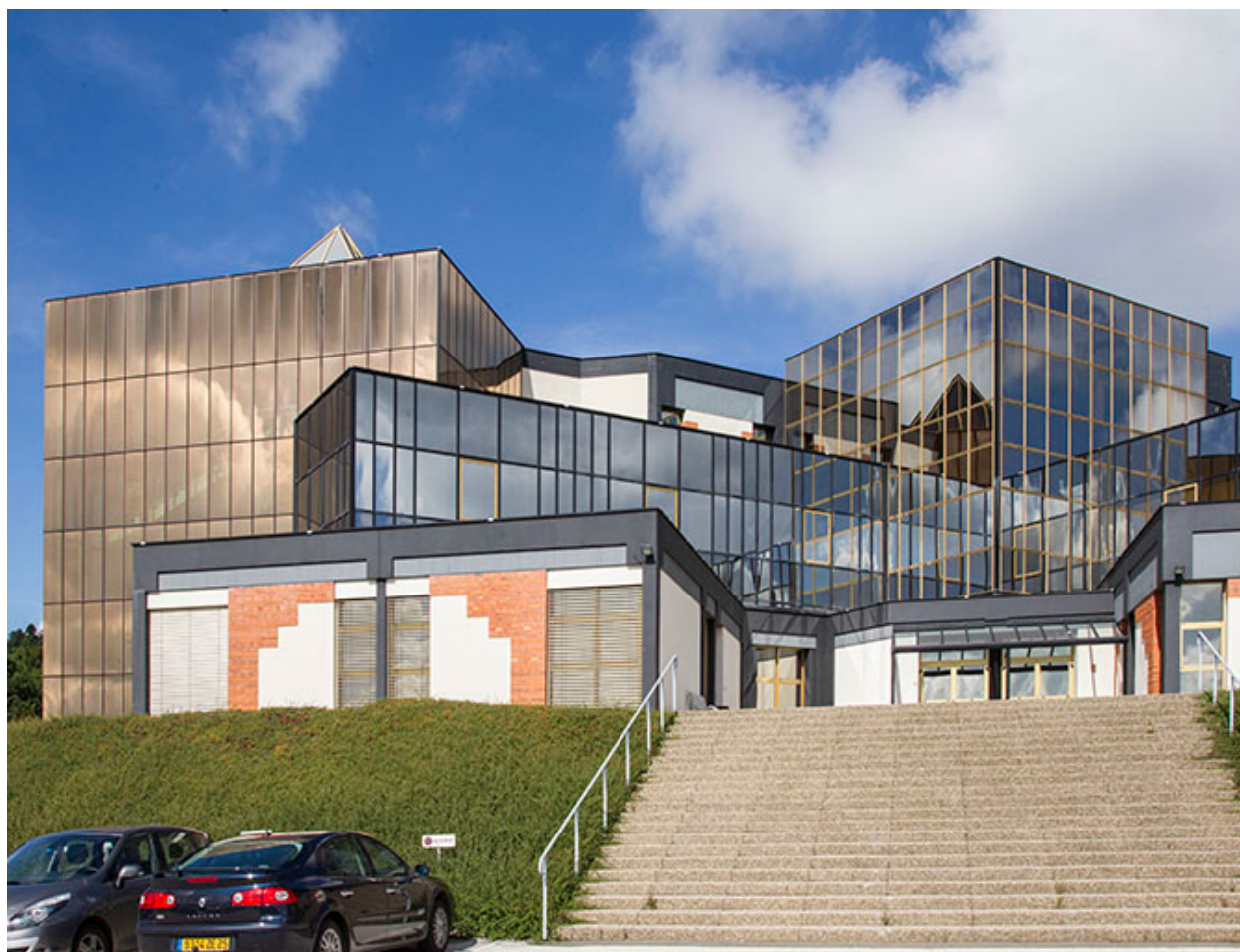
Vue rapprochée, depuis le sud-est, avec un escalier.
