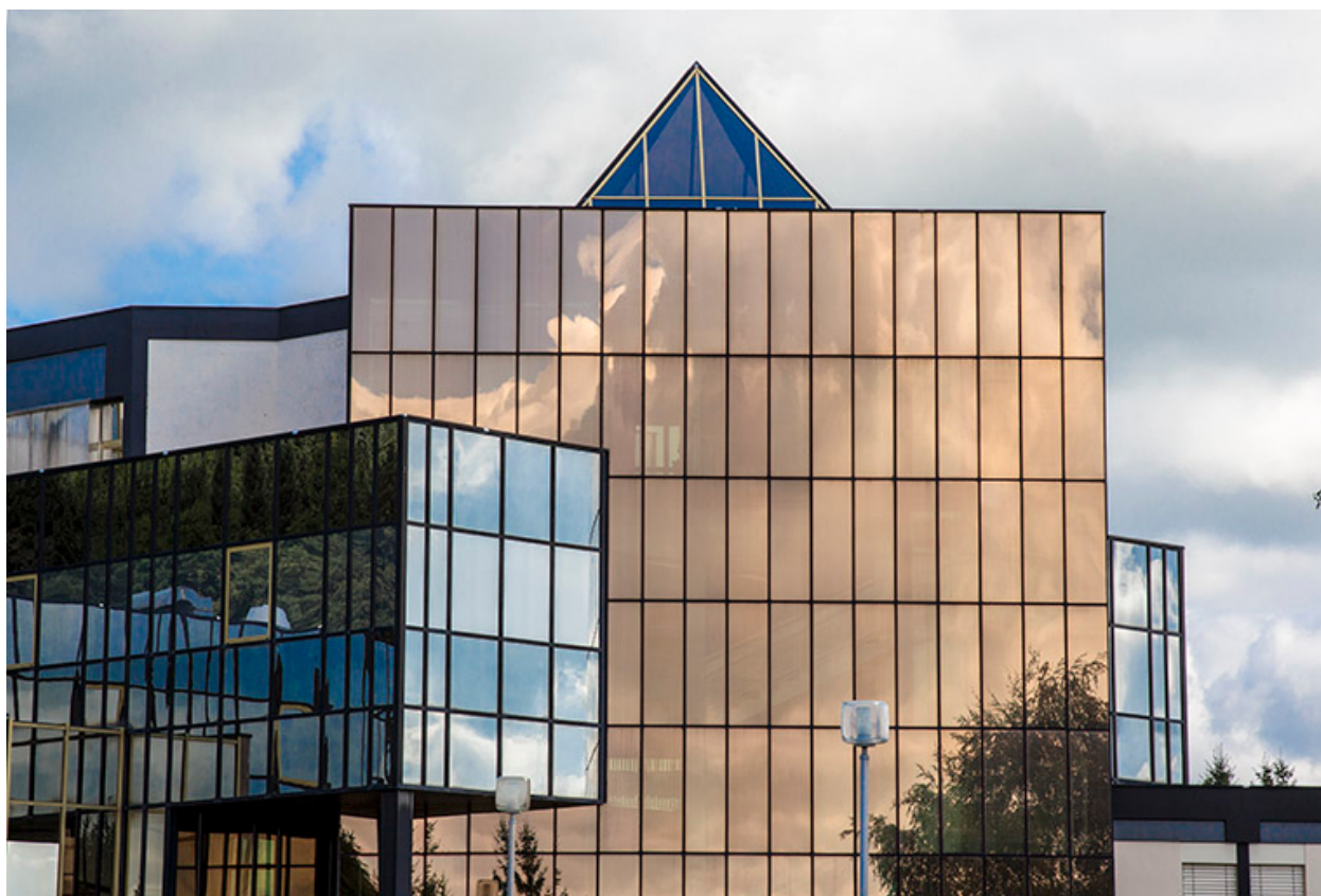
Bâtiment de l'escalier d'honneur, depuis le sud-ouest.
