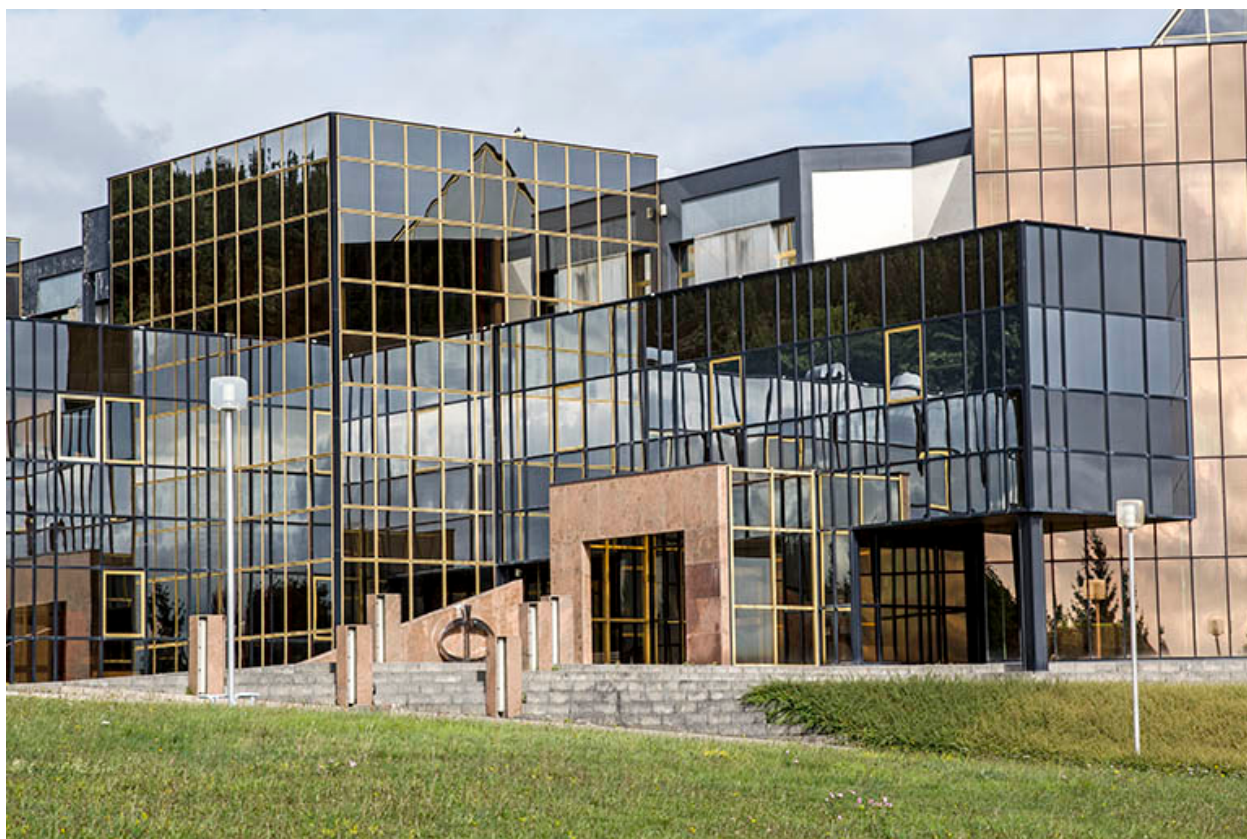
Entrée principale, depuis le sud-ouest.
