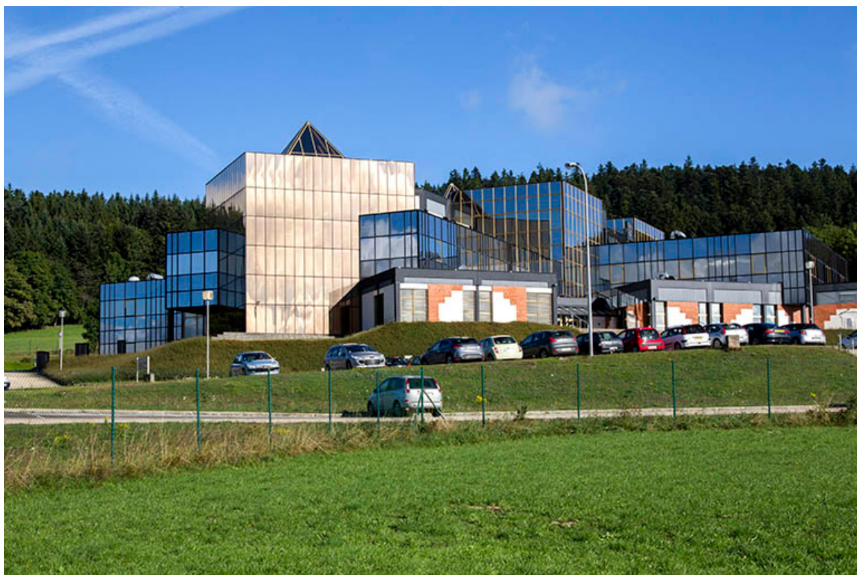
Vue d'ensemble rapprochée, depuis le sud.
