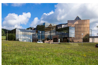
Vue rapprochée, depuis le sud-ouest.
