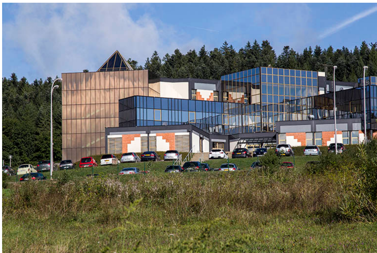
Vue rapprochée, depuis le sud-est.
