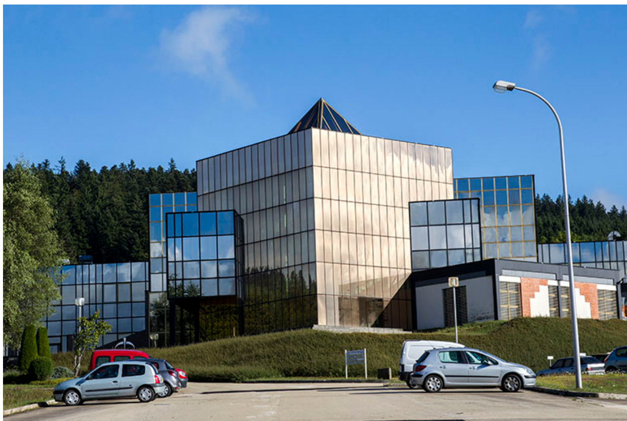
Vue rapprochée, depuis le sud, axée sur le bâtiment de l'escalier d'honneur.
