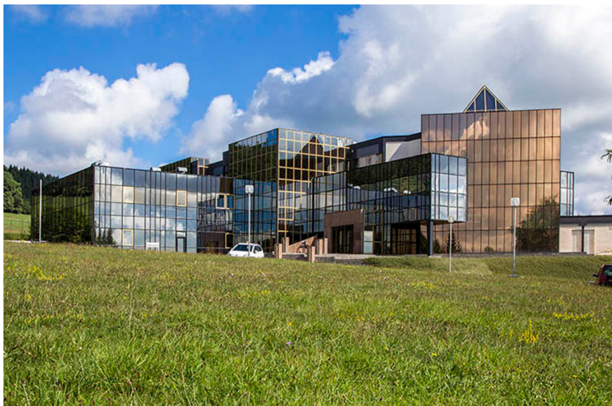
Vue rapprochée, depuis le sud-ouest.
