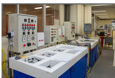
Atelier de traitement de surface : installation de galvanoplastie. Phot. Yves Sancey IVR43_20132502845NUC2A
