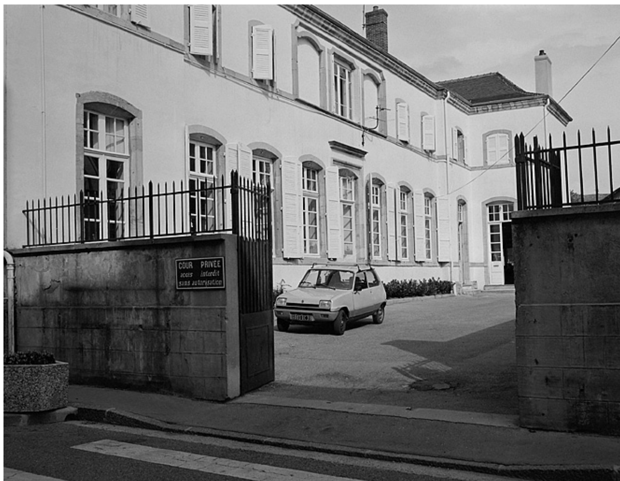
Façade postérieure, vue générale.
