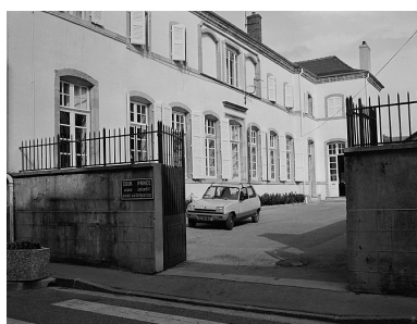
Façade postérieure, vue générale.
