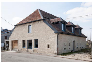
Vue depuis l'est. Phot. Jérôme Mongreville IVR43_20162500227NUC4A
