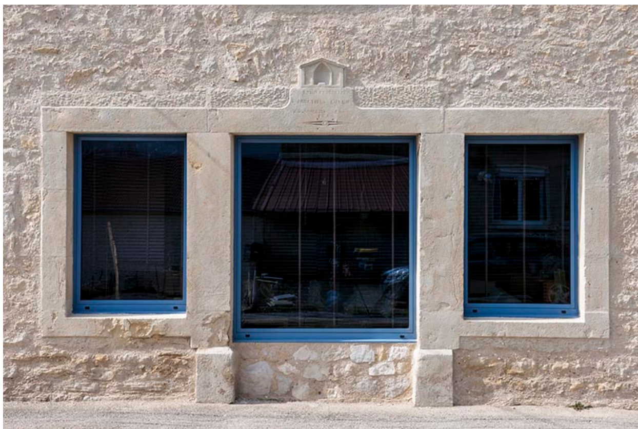
Ouvertures du mur-pignon est.
