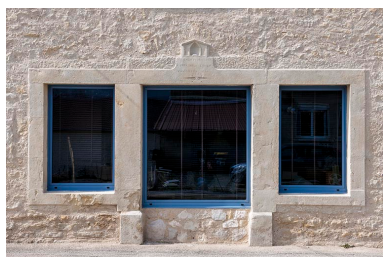
Ouvertures du mur-pignon est. Phot. Jérôme Mongreville IVR43_20162500229NUC4A
