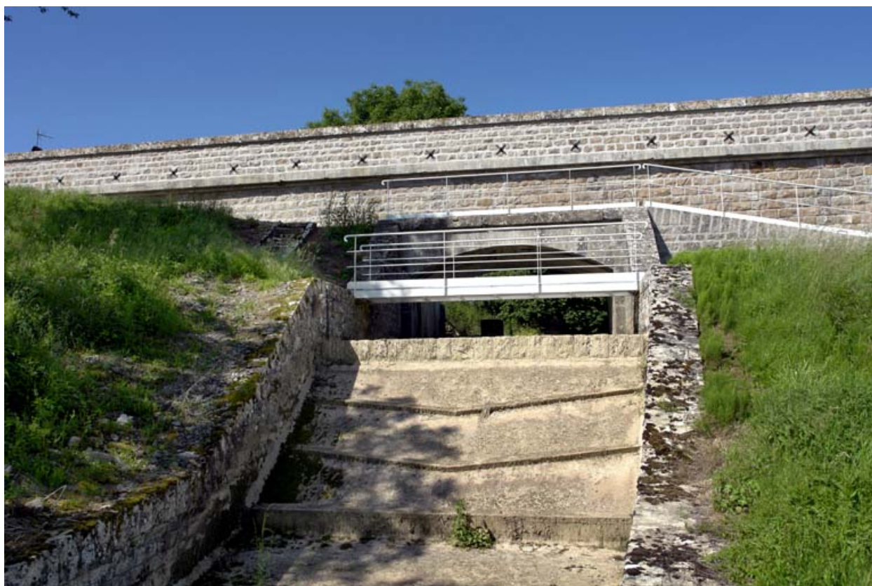
Déversoir de superficie du réservoir, prolongé par une chute d'eau en trois paliers et surmonté d'une passerelle.
