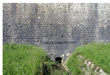
Face avant du barrage, sortie de la vanne de fond. Phot. Alain Morelière IVR26_20072106046NUC2A
