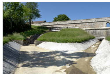
Rigole de décharge du déservoir de superficie qui rejoint celle de la tour de prise d'eau et de la vanne de fond. Phot. Alain Morelière IVR26_20072106045NUC2A
