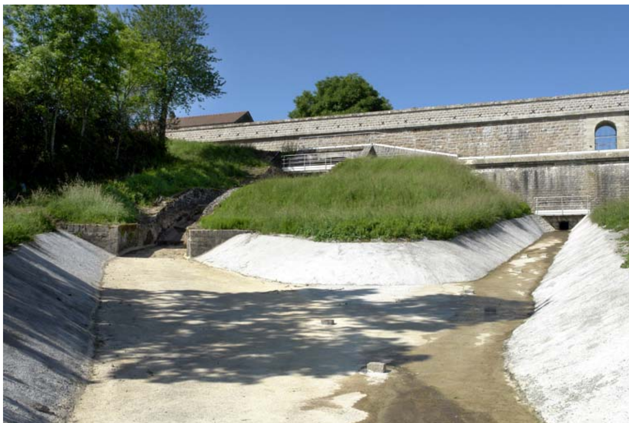
Rigole de décharge du déservoir de superficie qui rejoint celle de la tour de prise d'eau et de la vanne de fond.
