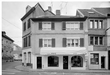
Façade sur rue. Phot. Jérôme Mongreville IVR43_19882500022V
