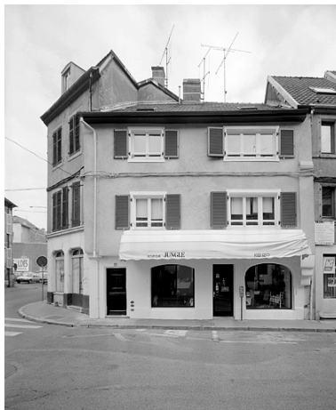
Façade sur rue. Phot. Jérôme Mongreville IVR43_19882500023V
