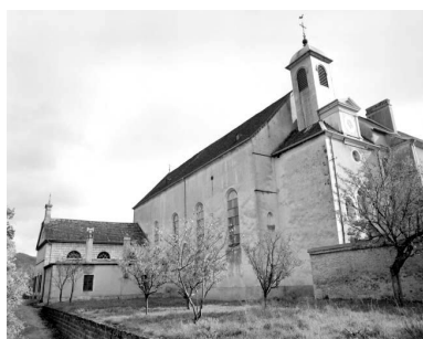
Façade latérale gauche de la chapelle. Phot. Yves Sancey IVR43_19762501306X
