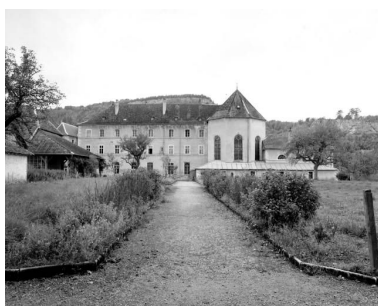
Vue générale depuis le nord. Phot. Yves Sancey IVR43_19762501293X
