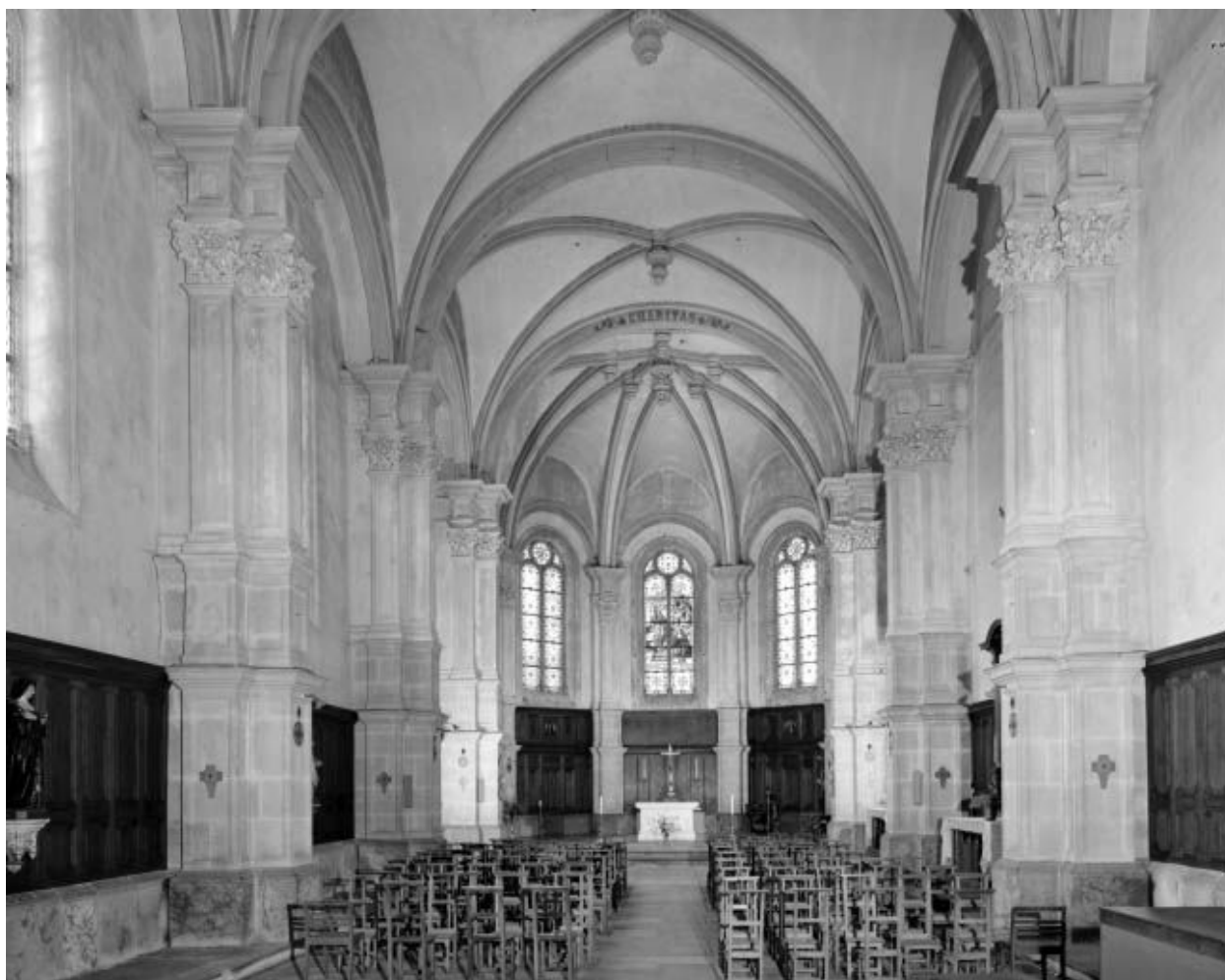
Intérieur : la nef et le chœur.
