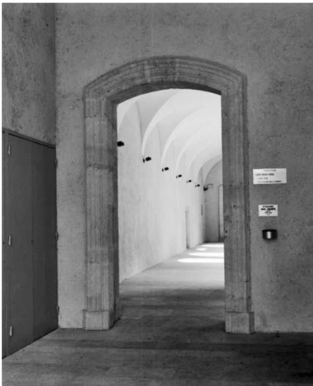
Intérieur : porte conduisant au cloître.
