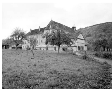
Vue générale depuis le verger, angle nord-ouest. Phot. Yves Sancey IVR43_19762501294X
