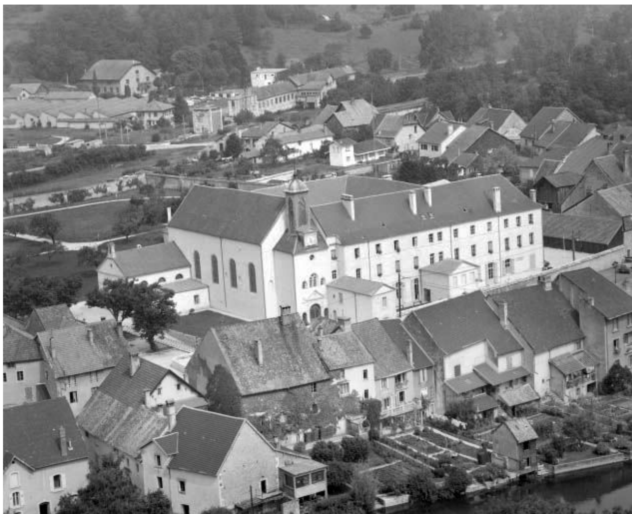
Vue générale après la rénovation de 1981-1983.
