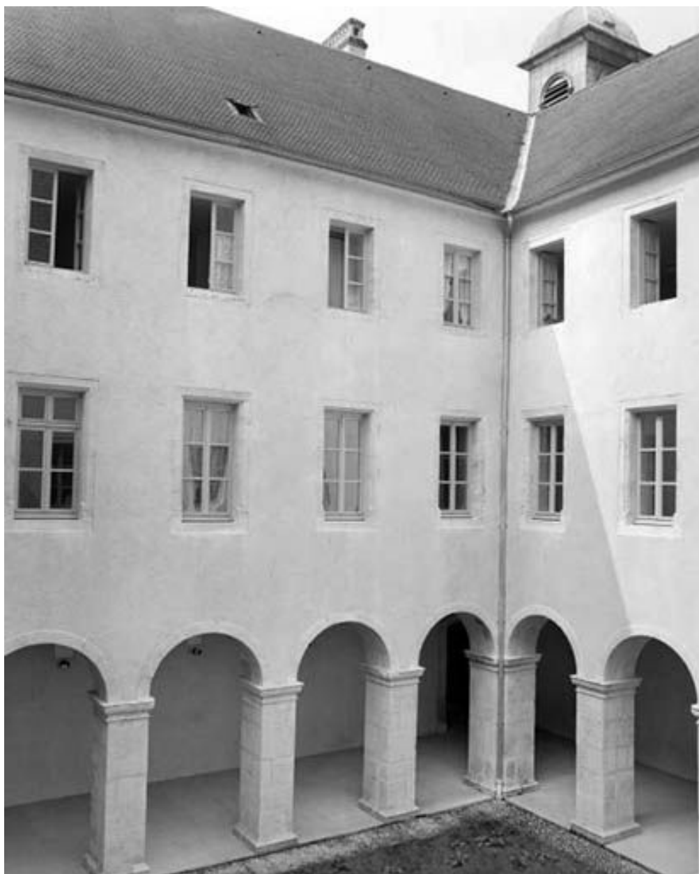
L'angle sud ouest du cloître.
