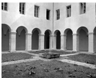
L'angle nord ouest du cloître. Phot. Yves Sancey IVR43_19842500013X
