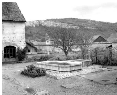
Vue générale de la fontaine, lavoir, abreuvoir. Phot. Yves Sancey IVR43_19762501297X
