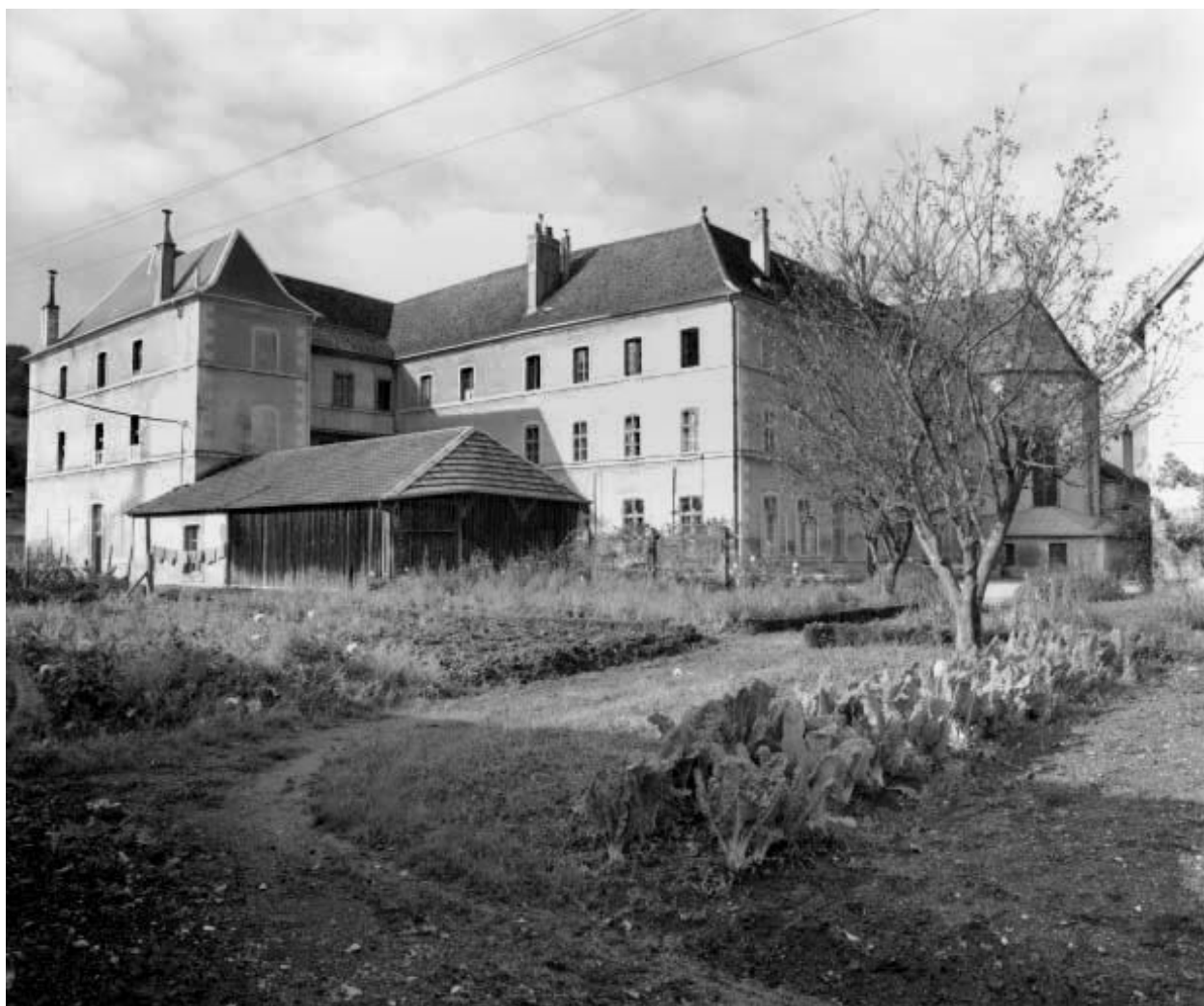
Vue d'ensemble des bâtiments depuis l'angle nord-est.
