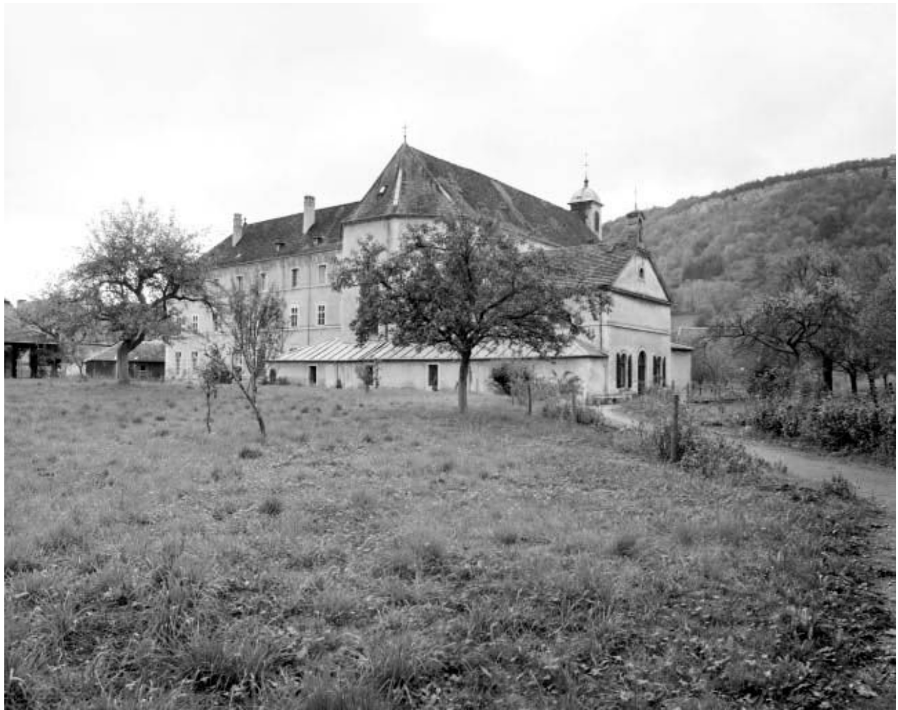
Vue générale depuis le verger, angle nord-ouest.
