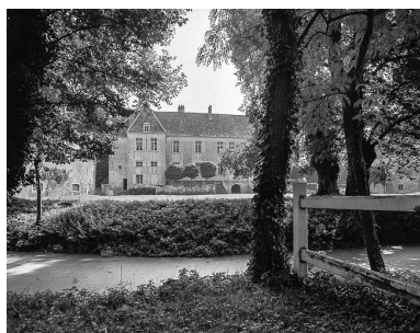
Façade antérieure et fossé. Phot. Yves Sancey IVR43_19757000315X
